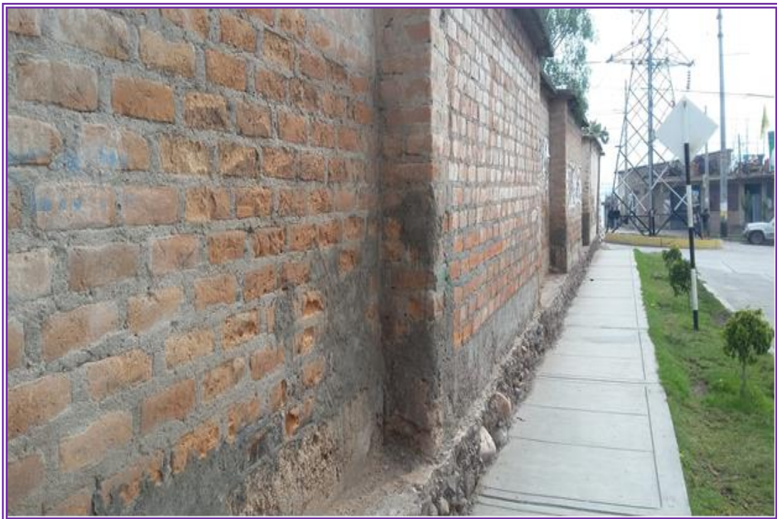
Figura 16: Desgaste por erosión de los muros UNSCH
