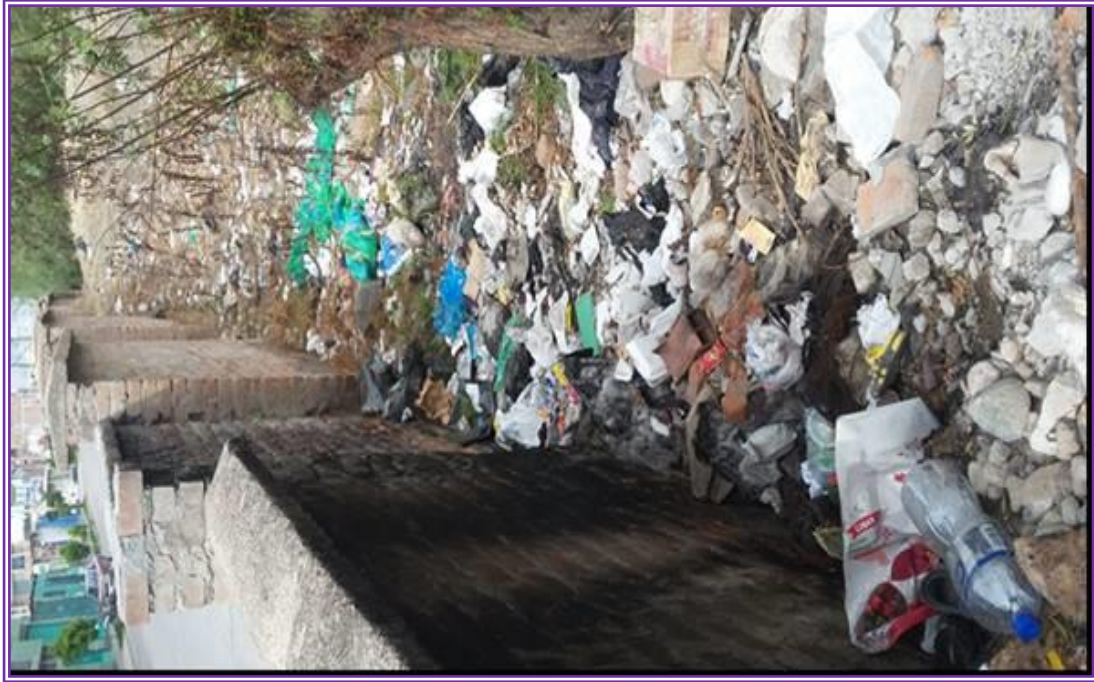
Figura 17: En la imagen se puede observar Humedad generada por las basuras.
