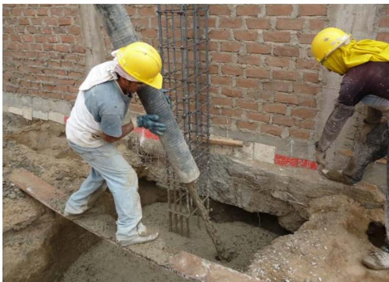
*Figura 22.* Vaciado de concreto premezclado utilizando una bomba estacionaria.
