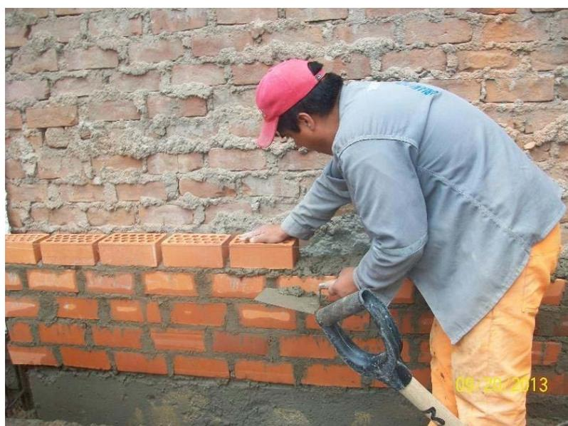
*Figura 16.* Albañil levantando un muro de albañilería de sogá con ladrillos de arcilla de 18 huecos.
