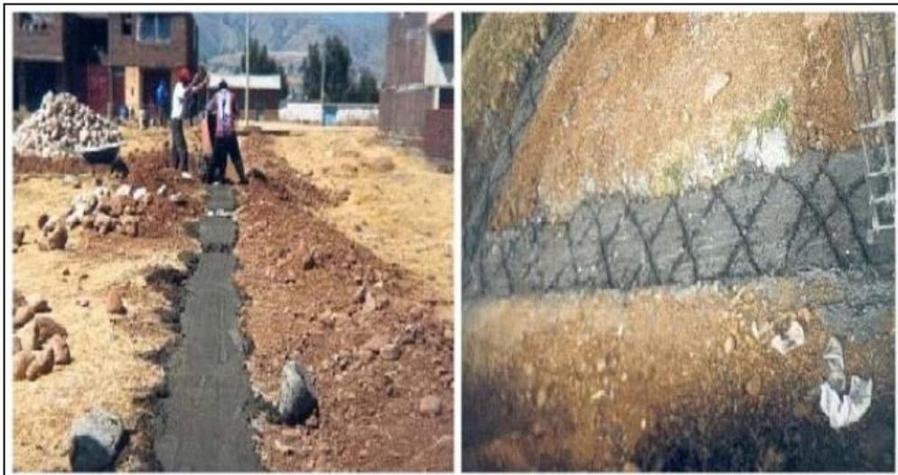
*Figura 13.* Cimentación de concreto simple.
