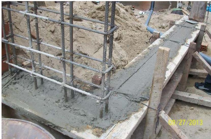
*Figura 17.* Sobrecimiento de concreto simple.
