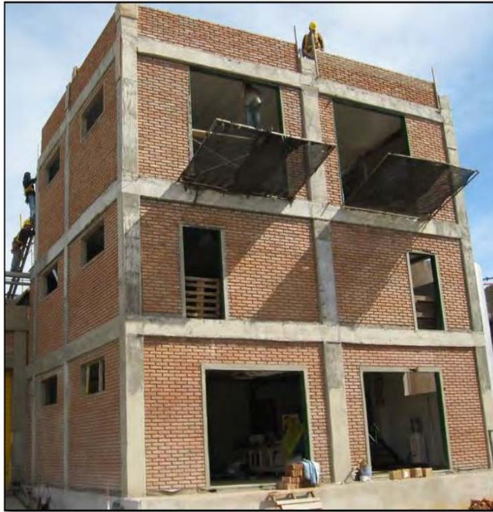
*Figura 7.* Edificación construida mediante sistema confinado.
