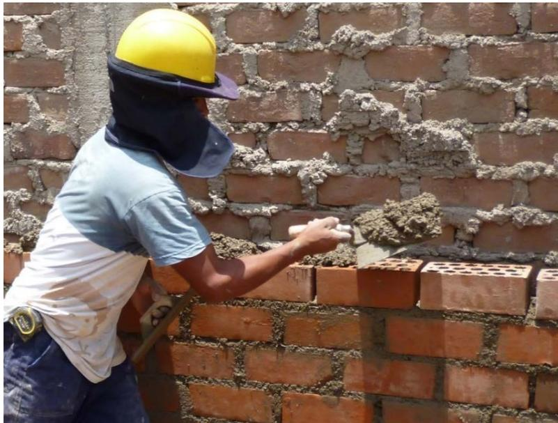
*Figura 20.* Albañil realizando la colocación del mortero para la colocación del ladrillo de un muro de albañilería.
