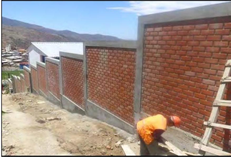
*Figura 35.* Elementos de cierre de cerco perimétrico aplicado mediante sistema confinado.
