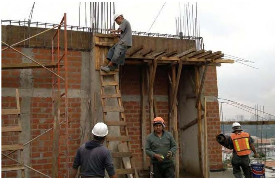
*Figura 9.* Construcción de muros de albañilería con elementos de confinamiento.
