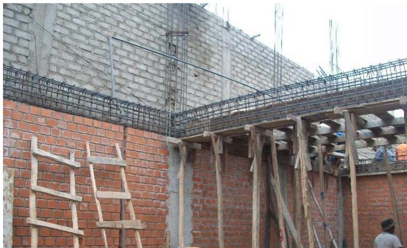
Figura 11. Armadura y encofrado de vigas de concreto armado.
