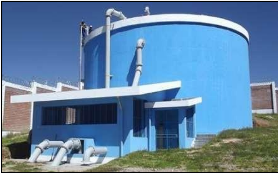
Ilustración 15. Reservorio apoyado
