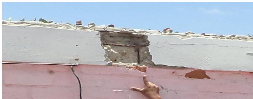
Imagen 6: Corrosión de acero corrugado.
