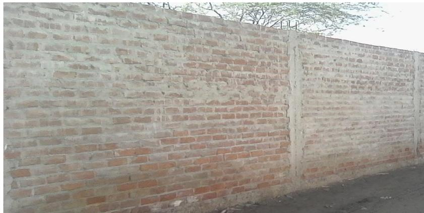
Imagen 4: Erosión en muro.
