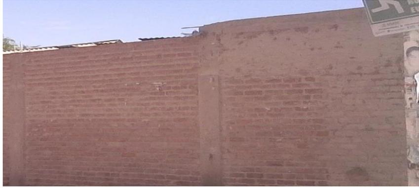
Imagen 5: Suciedad en muro de albañilería.
