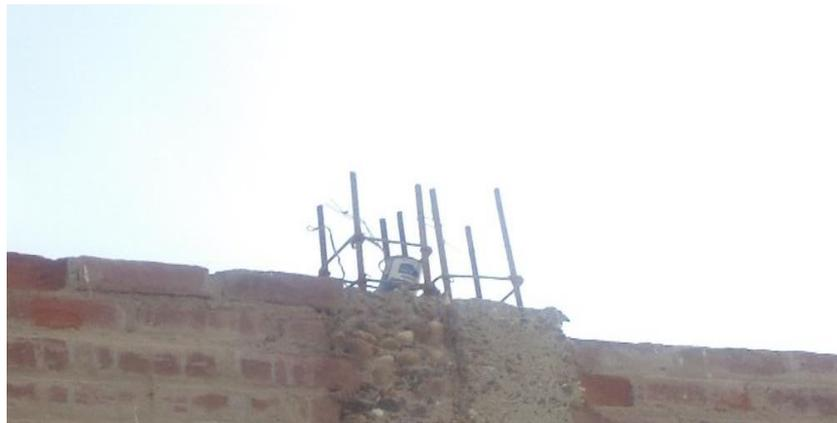
Imagen 9: Oxidación de acero corrugado.
