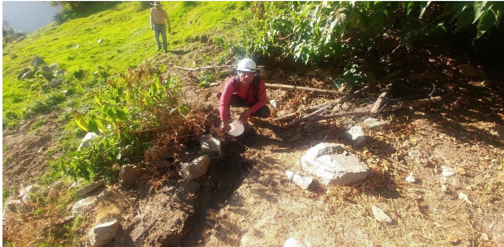
Fotos 03. Canalizando el agua de fuente para su posterior medición de caudal por el método volumétrico.
