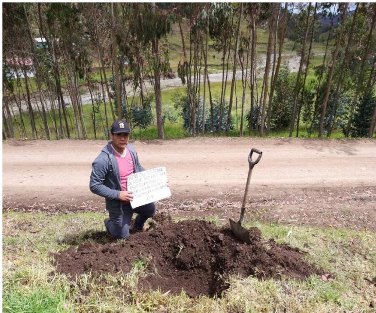
Fotos 08: Excavación de calicata 04 para para sus respectivos estudios de suelos.
