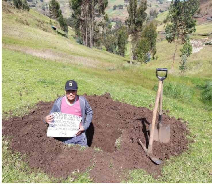
Fotos 07: excavación de calicatas para para sus respectivos estudios de suelos.
