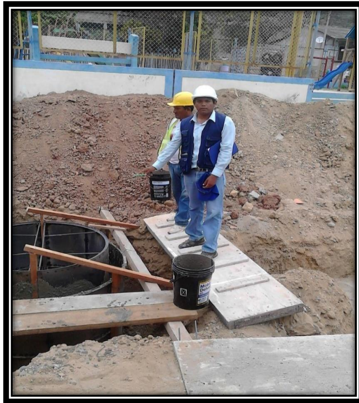
Grafica 8: Buzón instalado en obra. Fuente: Elaboración Propia.
