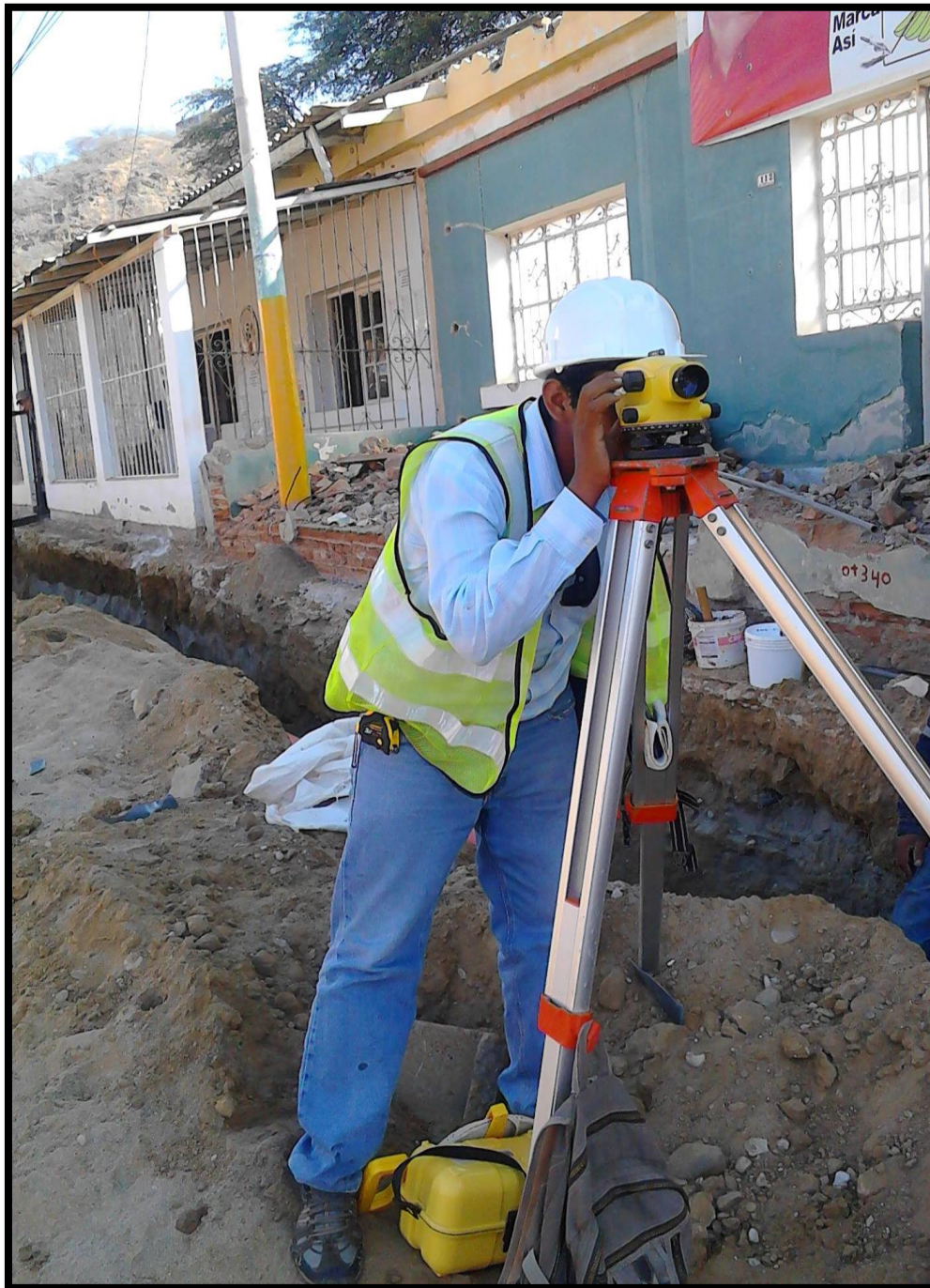
Imagen 1: Levantamiento topográfico de las calles del proyecto.
