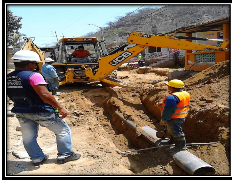
Grafica 4: Colector Secundario Ø 8" PVC Fuente: Elaboración Propia.
