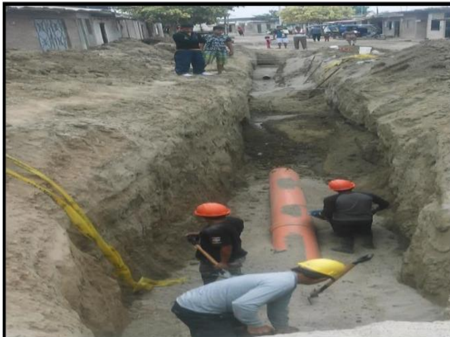
Grafica 5: Colector Principal Ø 18" PVC Fuente: Elaboración Propia. (2019).
