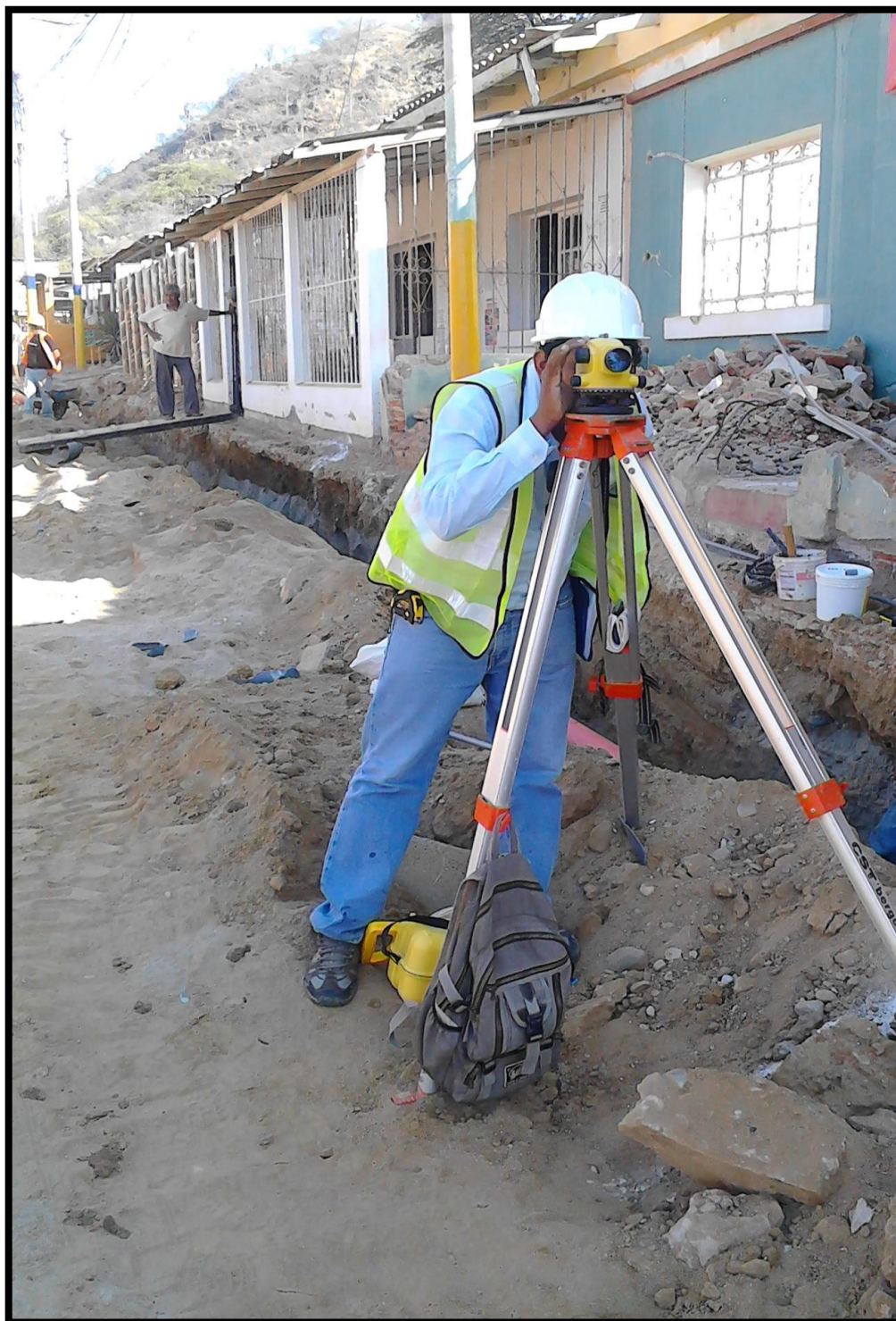
Imagen 2: Levantamiento topográfico en terreno natural.
