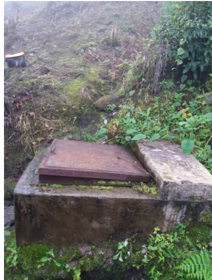
Fotografía N° 05: Cámara rompe presión tipo 6
