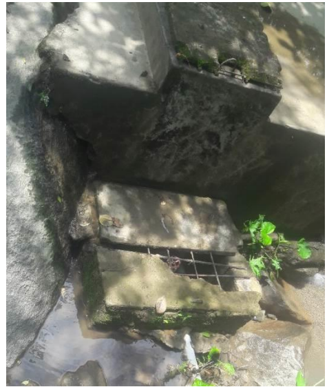
Fotografía N° 02: Captación superficial de agua
