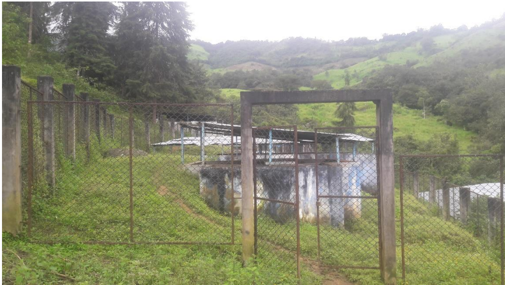
Fotografía N° 08: Planta de Tratamiento de Agua Potable
