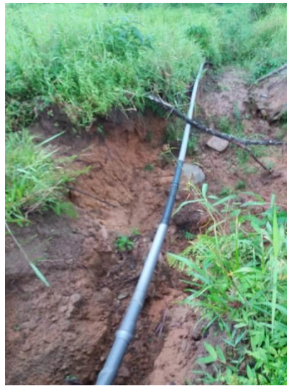
Fotografía N° 04: Tramo de tubería expuesta
