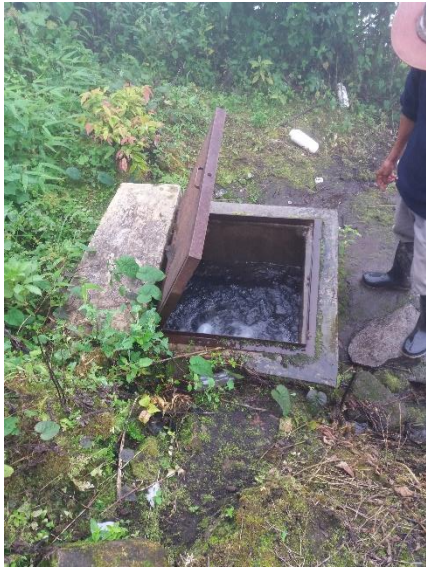
Fotografía N° 05: Cámara rompe presión tipo 6
