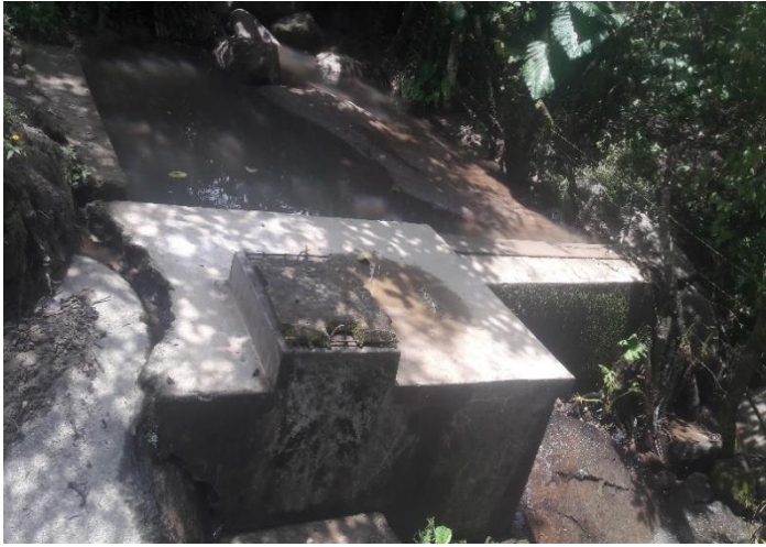
Fotografía N° 02: Captación superficial de agua
