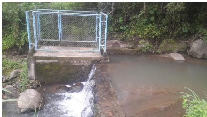
Fotografía N° 03: Captación superficial de agua
