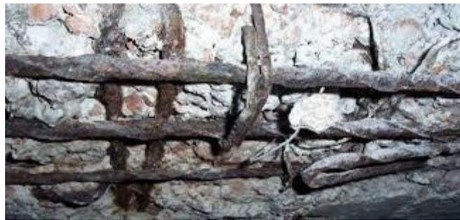
*Imagen 10 Ataques por corrosión*
