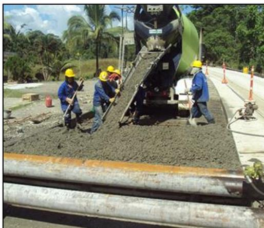
*Imagen 7 Concreto Premezclado*
