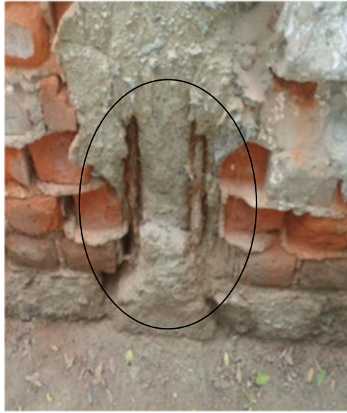
Fotografía 07 – Corrosión.
