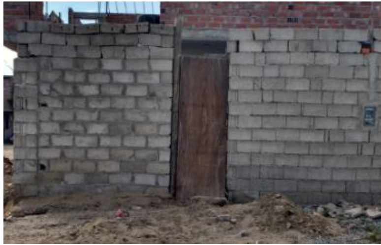
Figura 3. Construcción de albañilería simple con ladrillos cocidos. Nota. Fuente elaboración propia. (2016)
