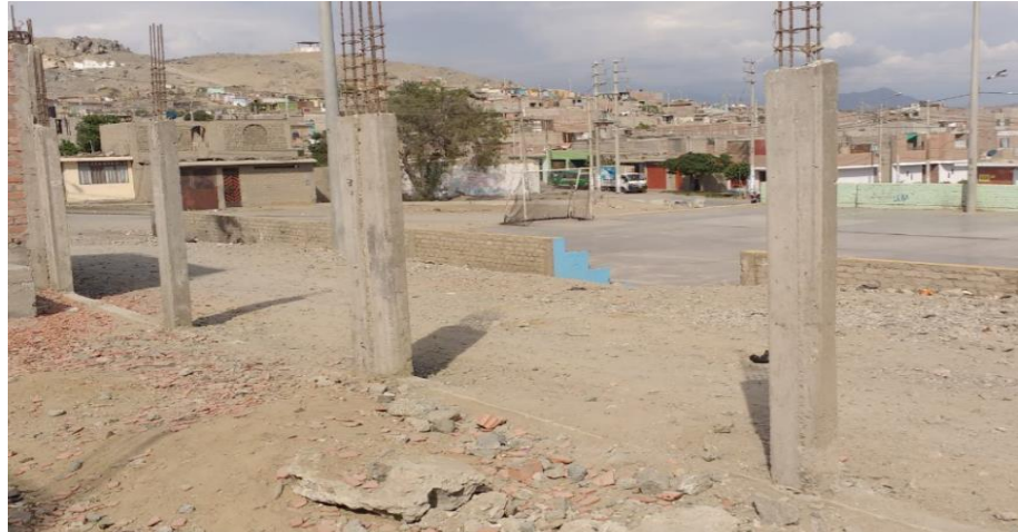
Figura 11. Columnas de albañilería. Nota. Fuente elaboración propia. (2016)
