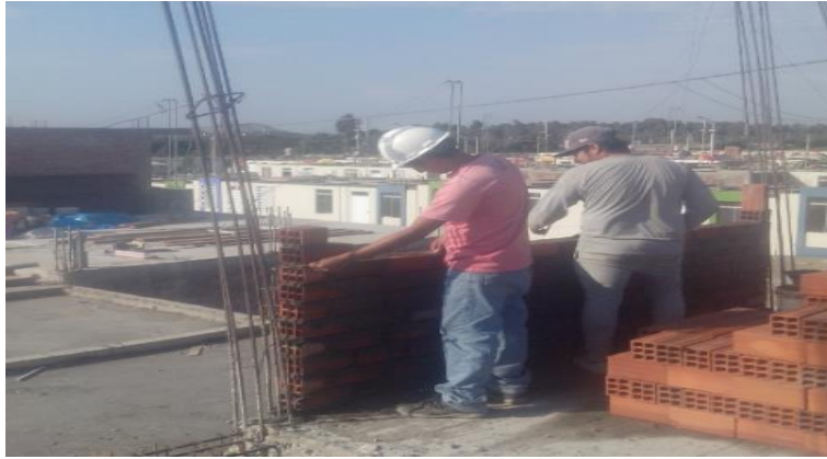
Figura 7. Construyendo muros de albañilería. Nota. Fuente elaboración propia. (2016)
