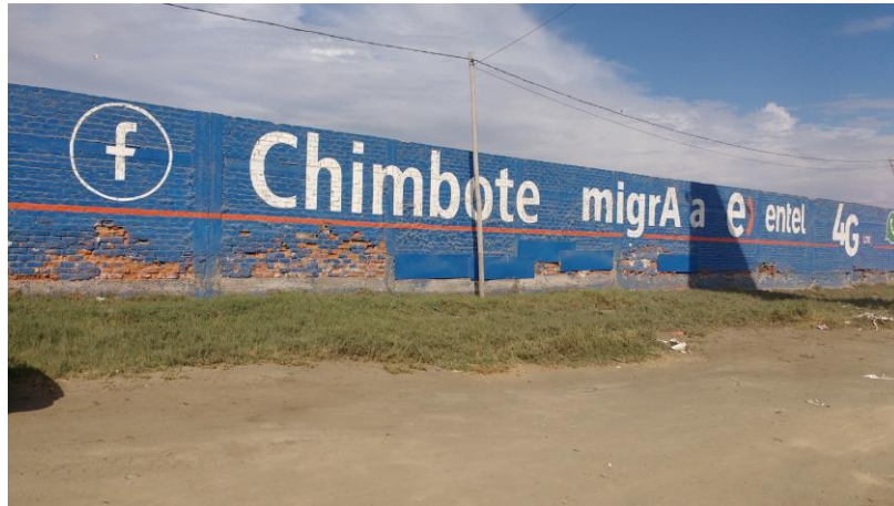
Figura 24. Patologías en muros. Nota. Fuente elaboración propia. (2016)
