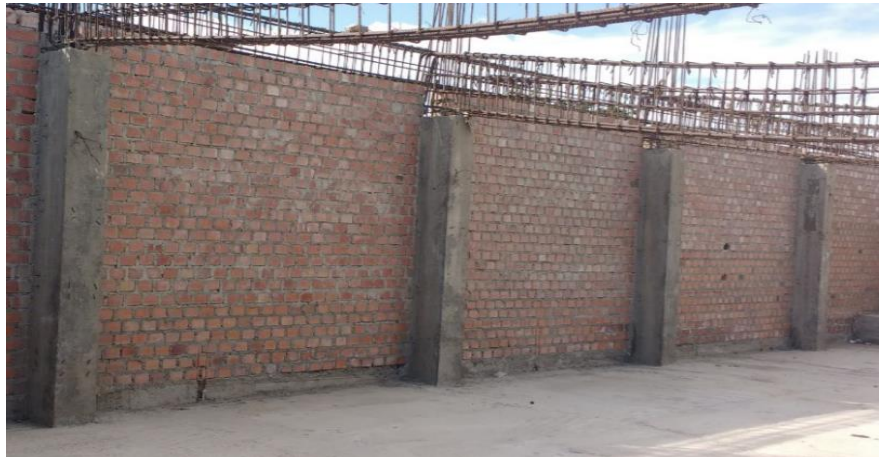
Figura 12. Columna de concreto armado. Nota. Fuente elaboración propia. (2016)
