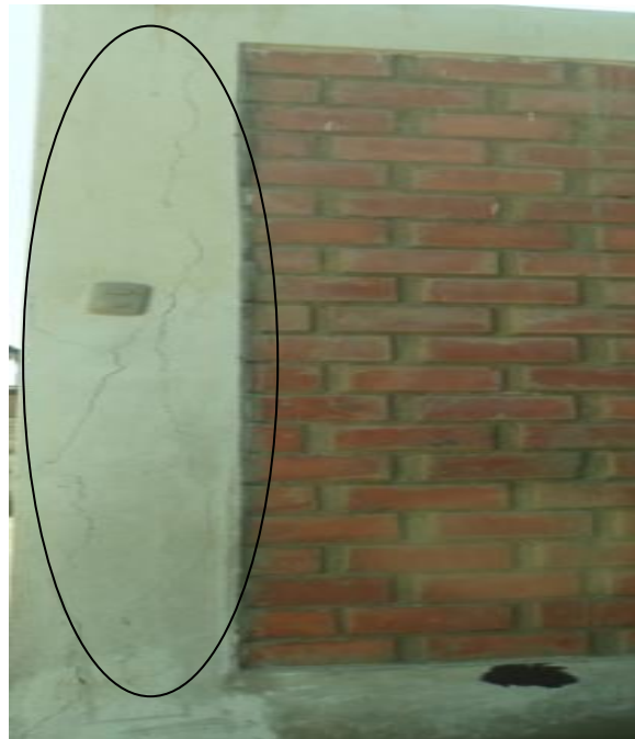
Fotografía 06 –Fisurada.
