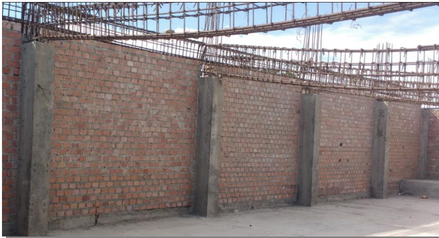
Figura 5. Construcción con elementos de refuerzos horizontales. Nota. Fuente elaboración propia. (2016).
