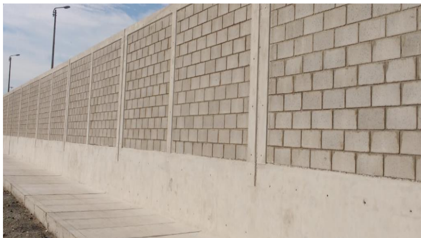
Figura 9. Construcción de muro portante. Nota. Fuente elaboración propia. (2016)
