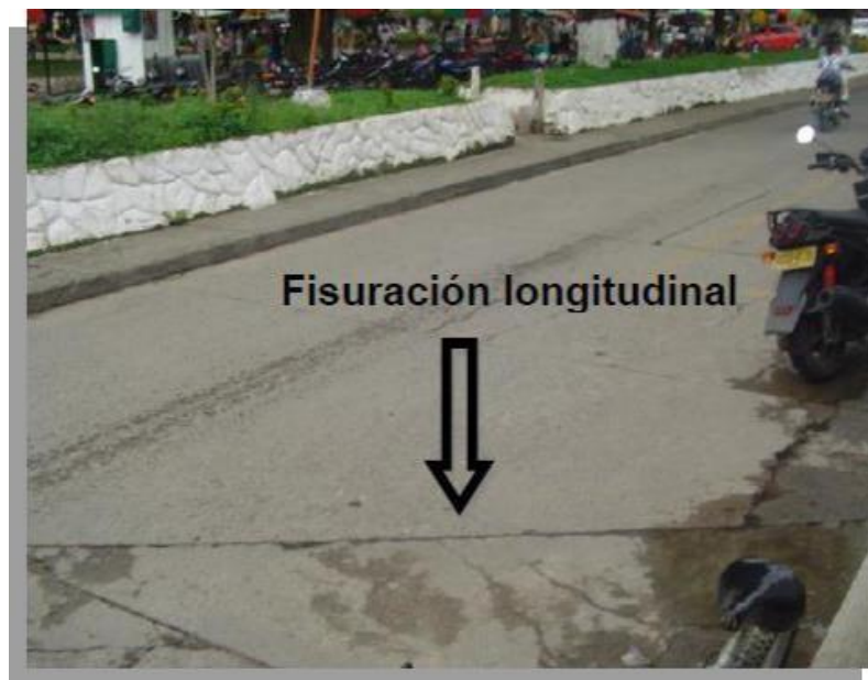
Gráfico N°02: Fracturamiento en las losas
