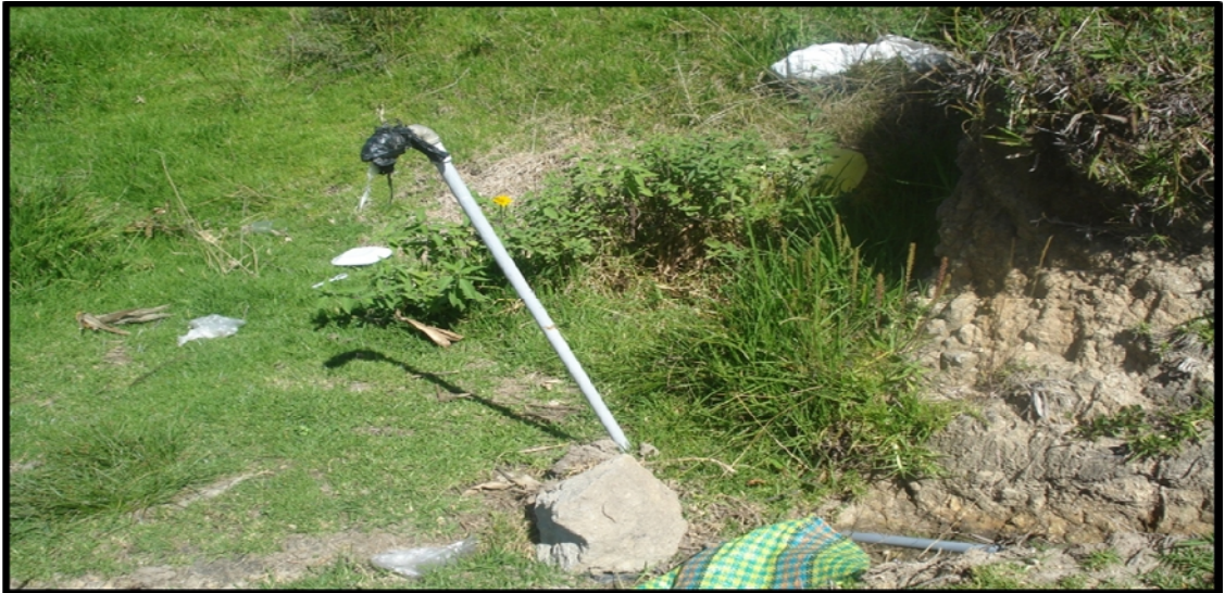
Fotografía 14. Caño malogrado
