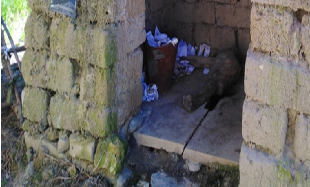
Fotografía 19. Interior de la letrina
