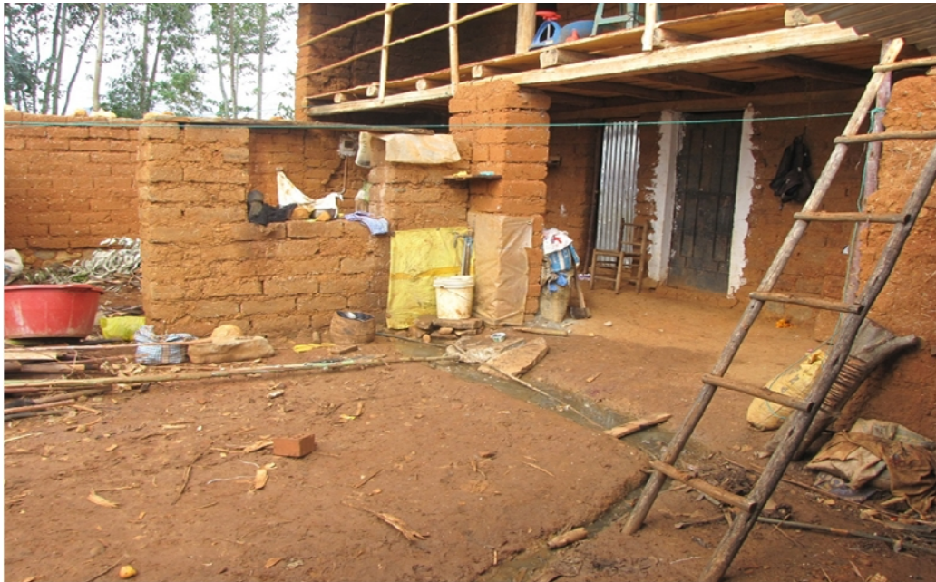
Fotografía 12. Vivienda con caño y sin desagüe
