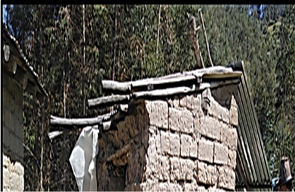
Fotografía 17. Techo de letrina
