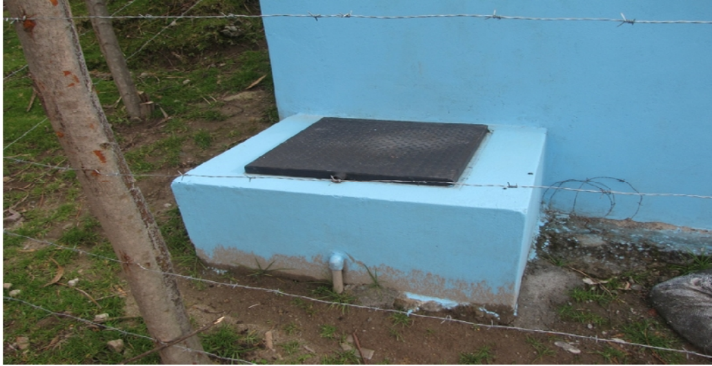
Fotografía 7. Cámara de válvulas
