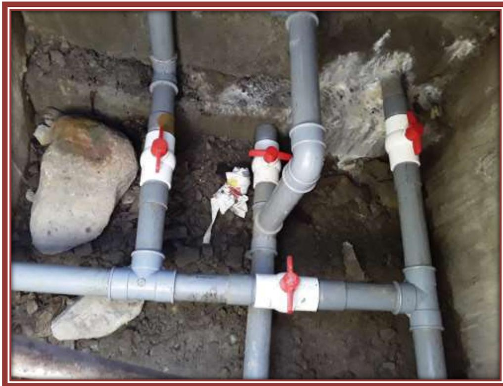
Fotografía 17: Cámara de válvulas.
