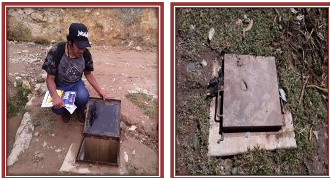
Fotografía 18: Válvulas de control deteriorados.
