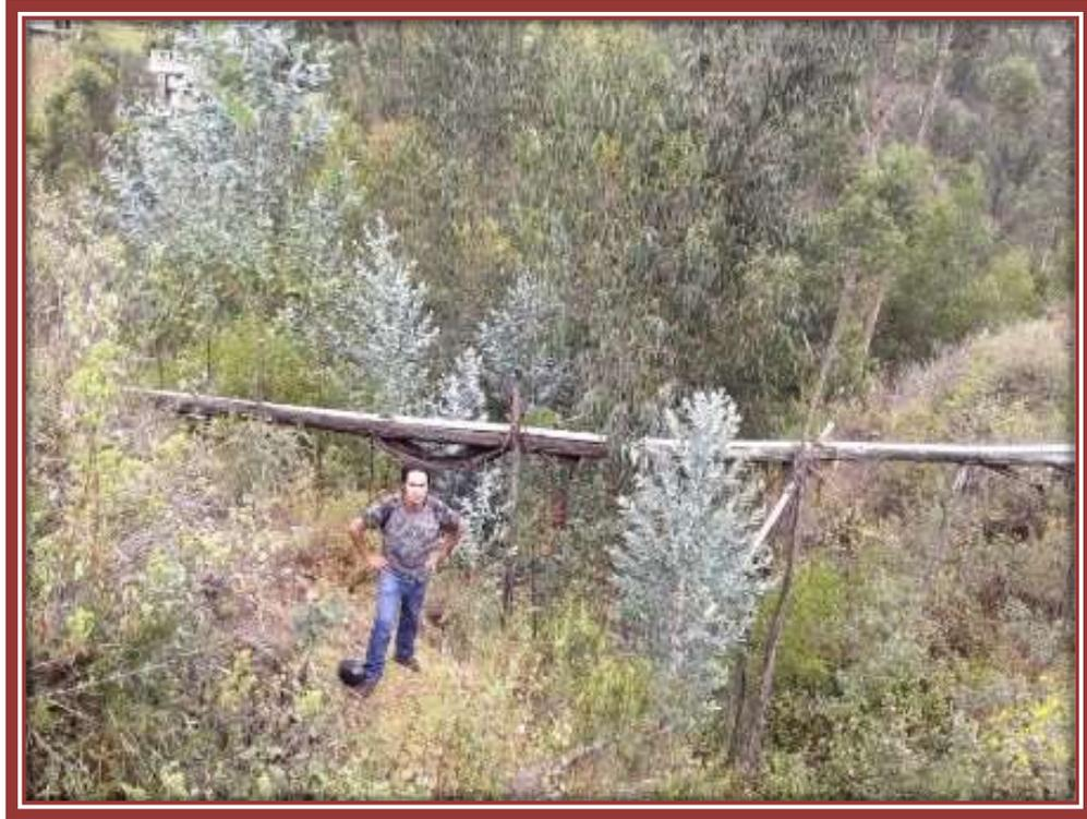
Fotografía 07: Tubería PVC 4" expuesta en quebrada (L=22.20 m).
