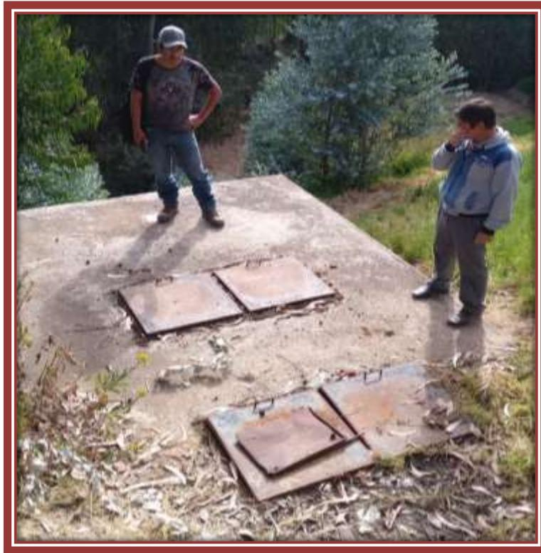
Fotografía 21: Tanque séptico de la PTAR 01 (Pariac Alto).
