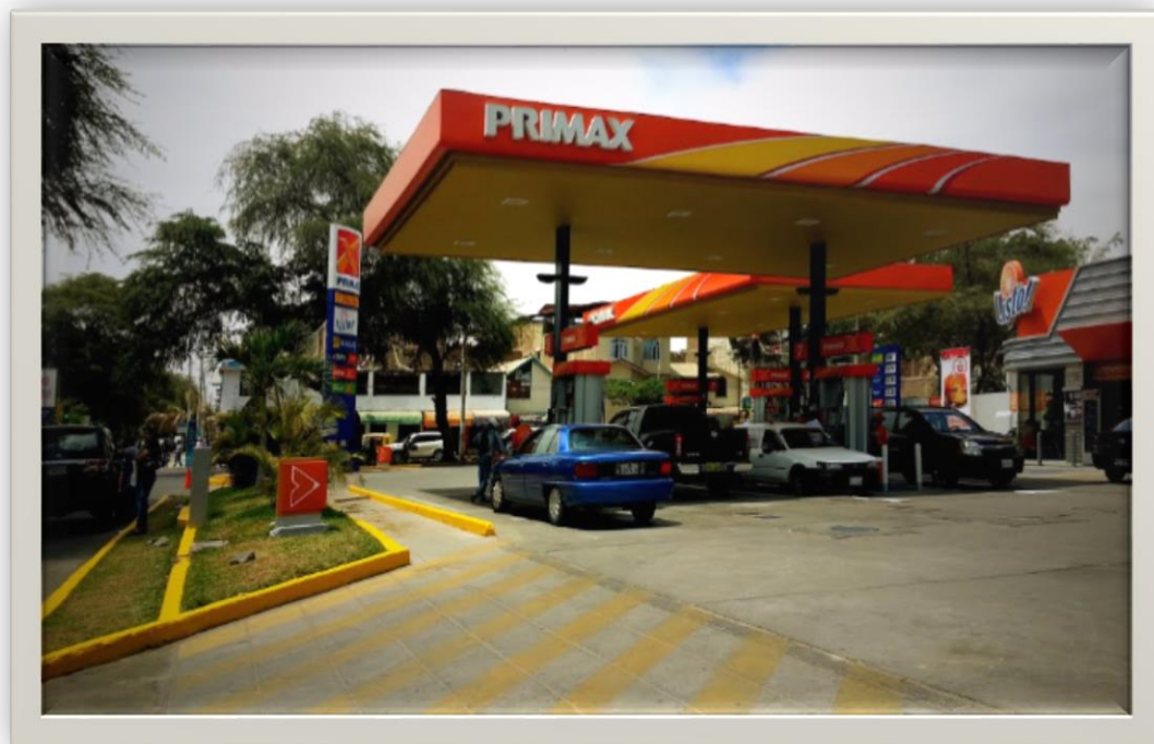
EMPRESA PRIMAX S.A- PIURA
