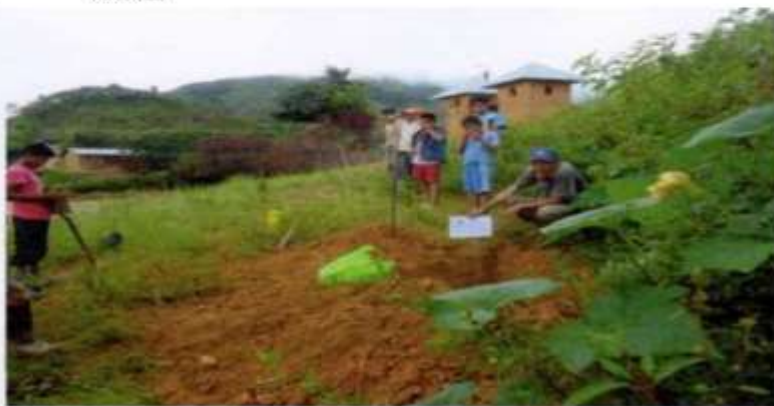
VISTA PANORAMICA DE LA CALICATA N°03 (LINEA DE CONDUCCION) – LOC. HIERBA BUENA - COLASAY
