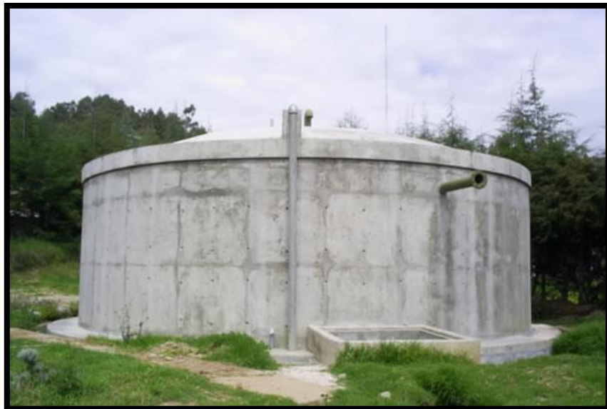
Figura 16. Reservorio circular apoyado.
