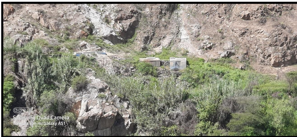
Imagen 01: vista panorámica de las estructuras hidráulicas existentes del sistema de abastecimiento de agua potable del caserío de huanca.
