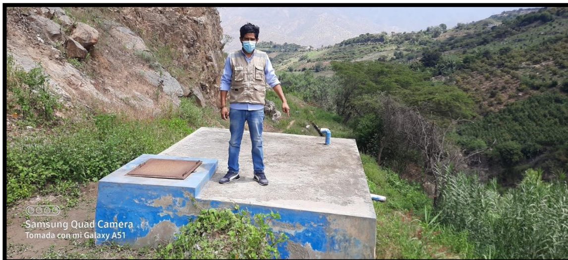
Imagen 02: reservorio existente 01 del sistema de abastecimiento de agua potable del caserío de huanca.
