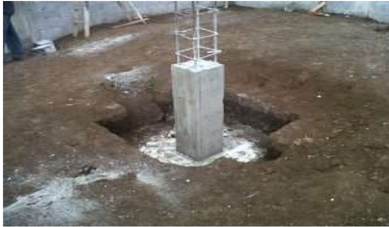
Figura 13: Construcción de una Columna cuadrada.
