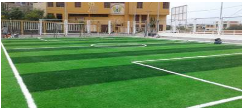
Figura 5: Cerco perimétrico de un campo deportivo en Áncash.
