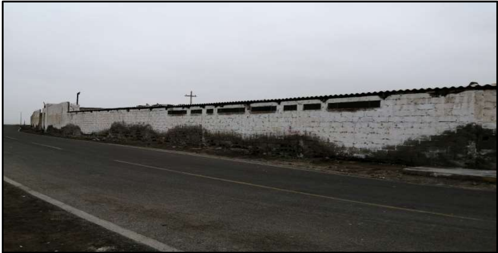
Fotografía 3: Vista del tramo 3 – 4 del cerco perimétrico de la Fábrica Corporación del Mar S.A., Distrito de Comandante Noel, provincia de Casma, región Áncash.
