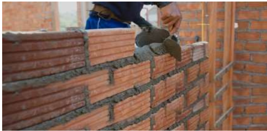
Figura 10: Muro de Albañilería Simple.
