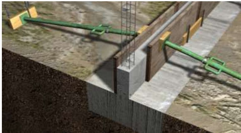
Figura 12: Encofrado de un Sobrecimiento.
