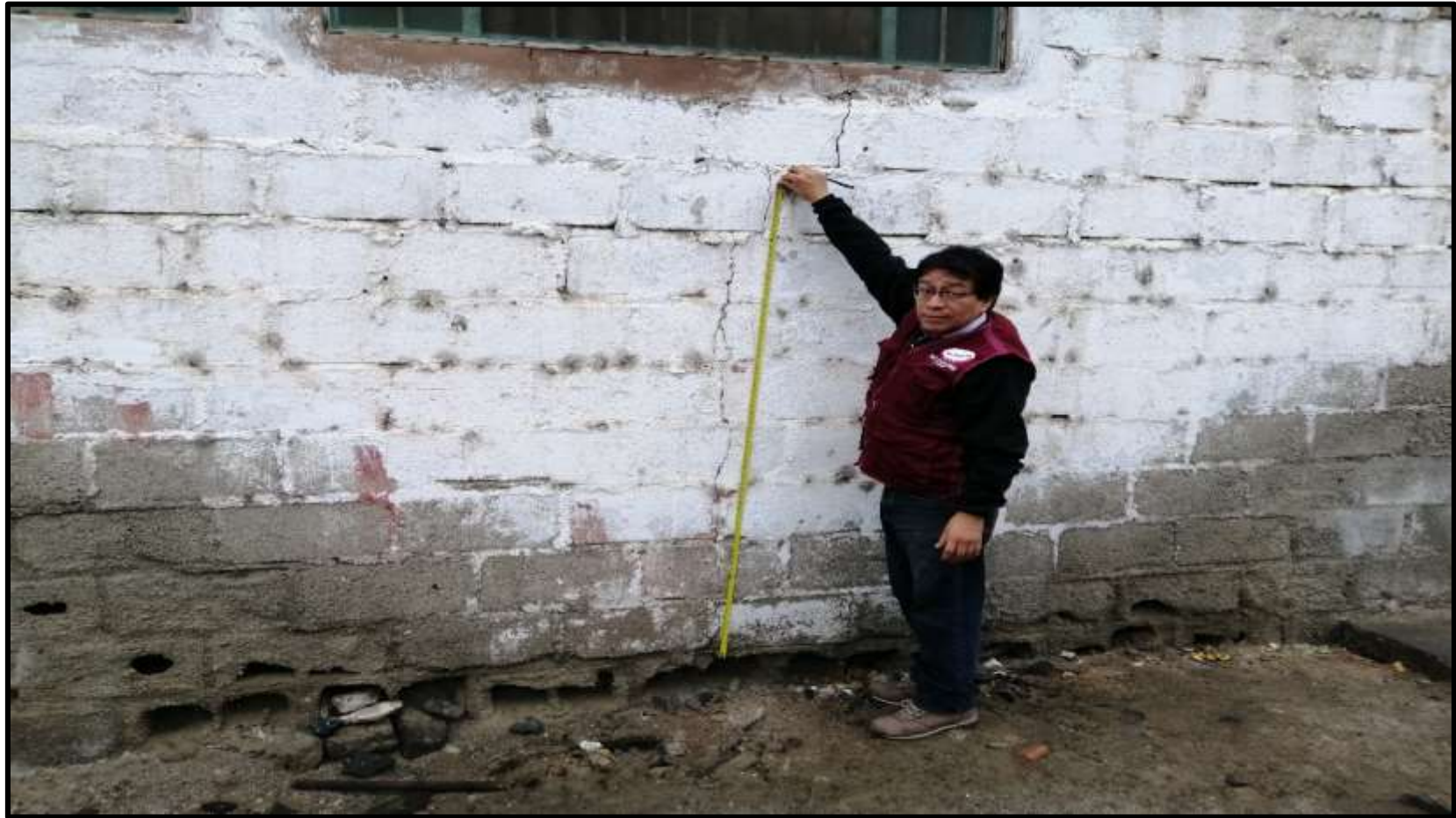
Fotografía 17: Midiendo la patología Fisura presente en el Muro de la Fábrica Corporación del Mar S.A. en la Unidad Muestral 02.
