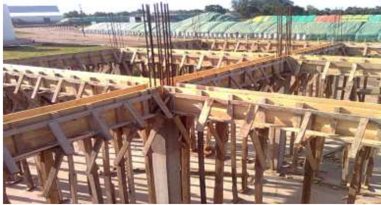
Figura 15: Encofrado de Vigas.
