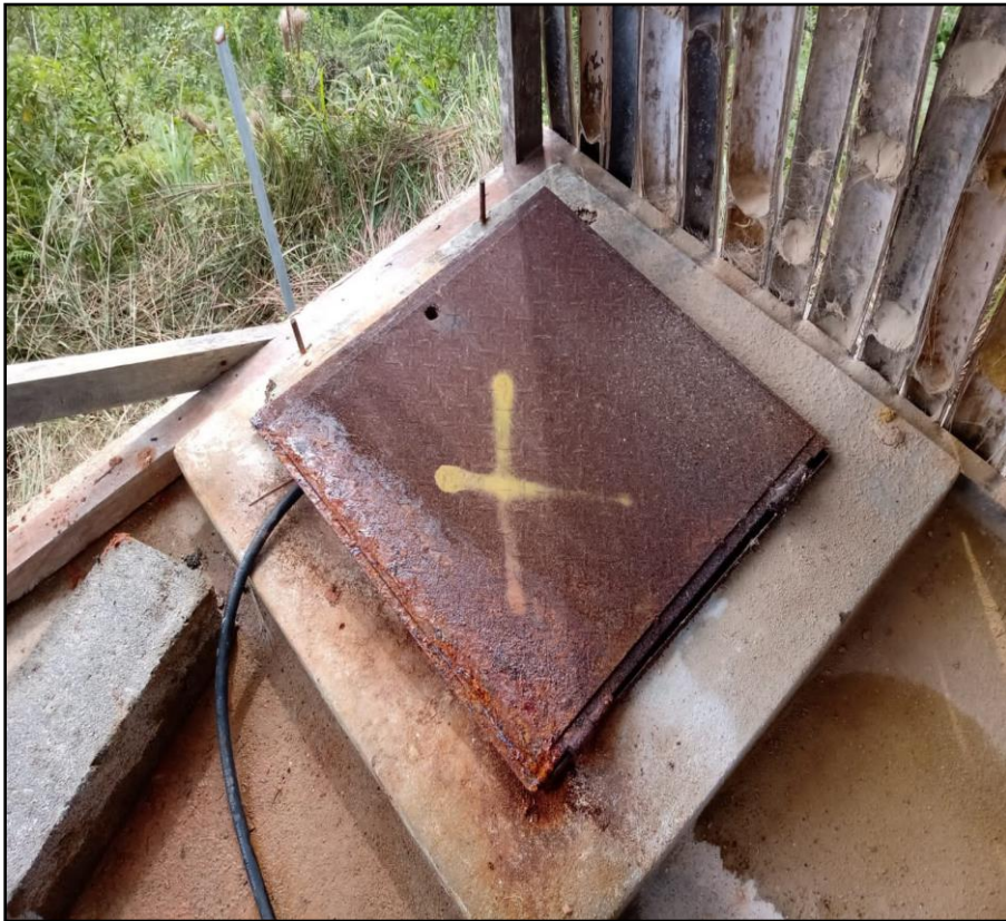
Figura 33: Tapa metálica de reservorio existente
