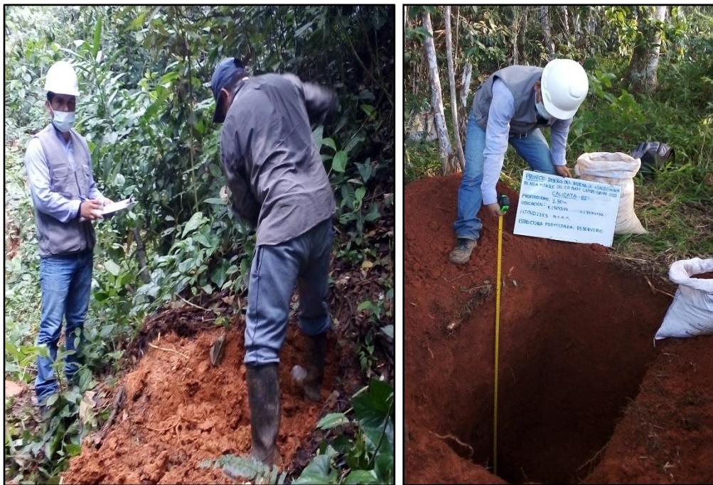
Figura 27: Excavación de la Calicata 02
