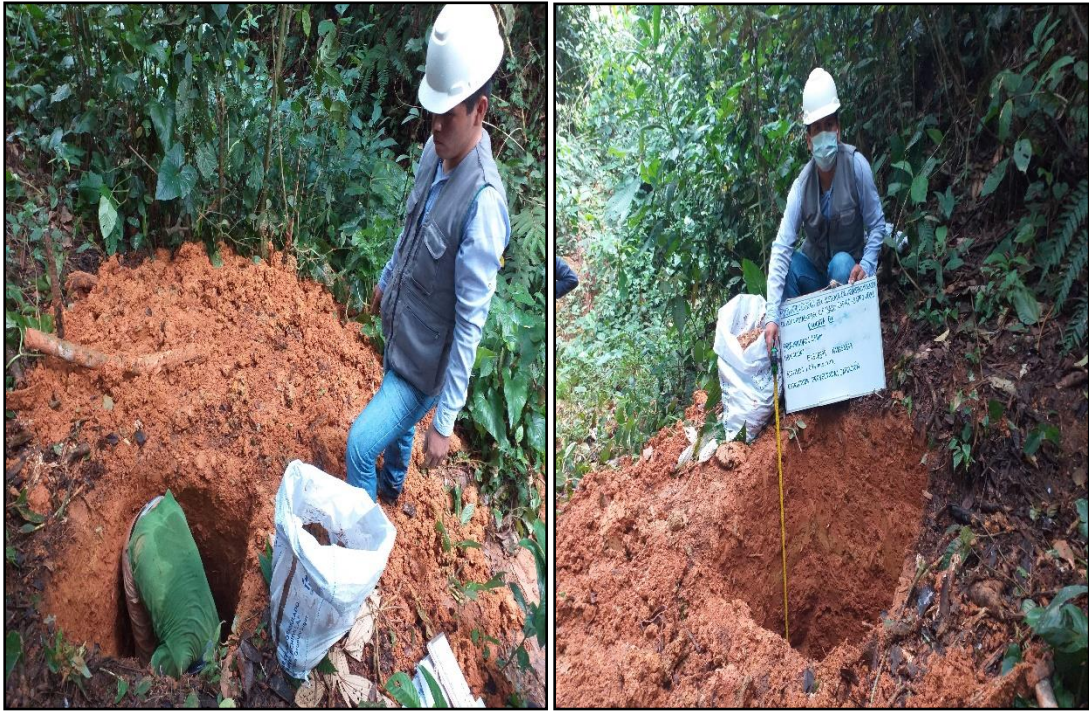
Figura 26: Excavación de Calicata 01
