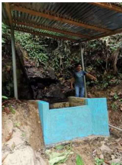
Figura 32 Inspección de Captación
