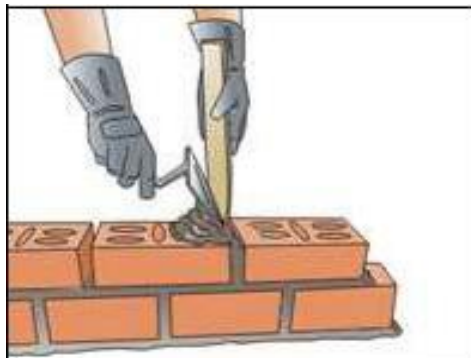
Figura 01. Colocación del mortero
