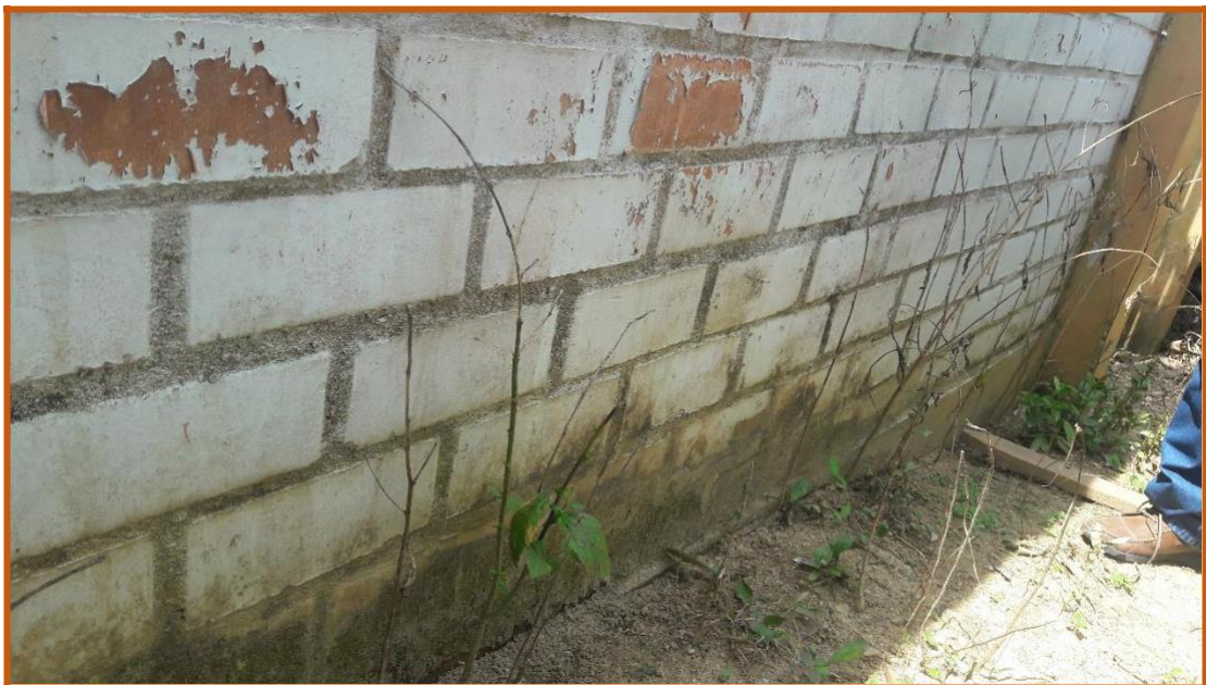
Figura 28. Se puede apreciar la patología [11] Desintegración.
