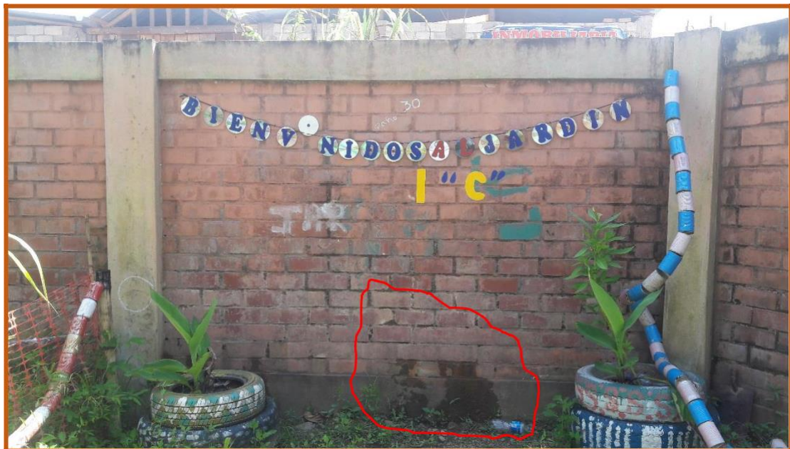
Figura 26. Se puede apreciar la patología [6] Agrietamiento Vertical.
