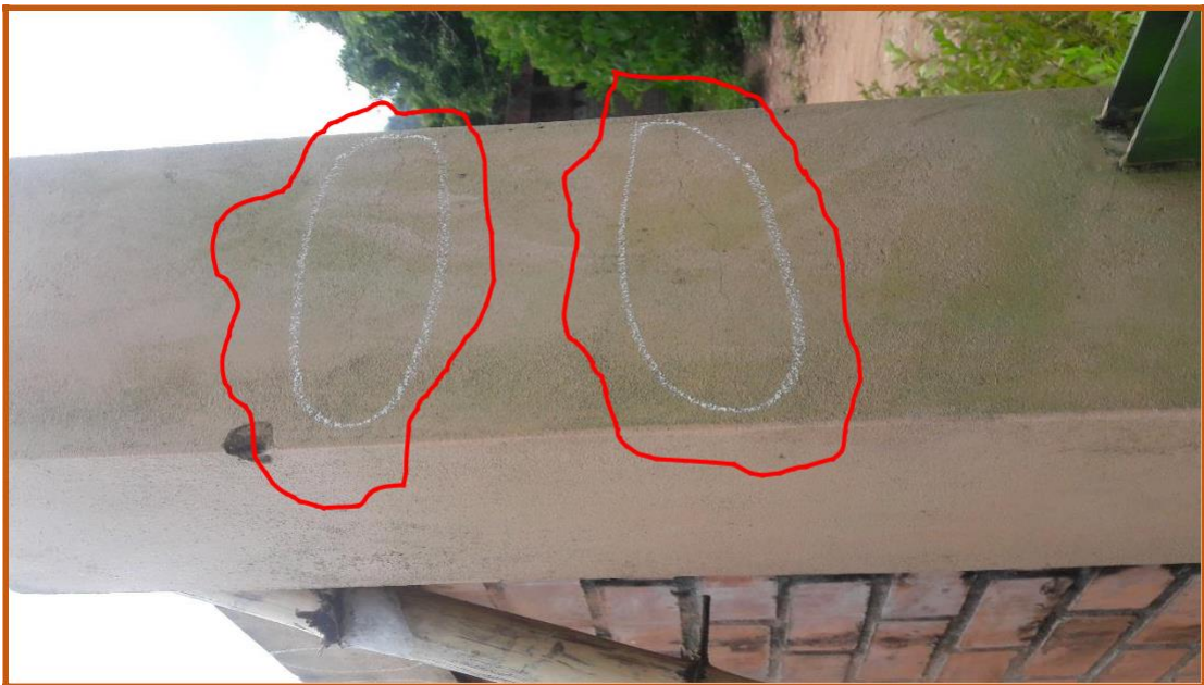
Figura 24. Se puede apreciar la patología [1] Erosión.
