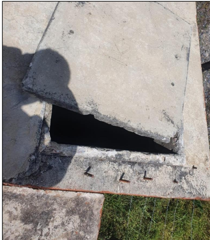
Fotografía 6: Se observa la tapa de reservorio existente (cámara húmeda).
