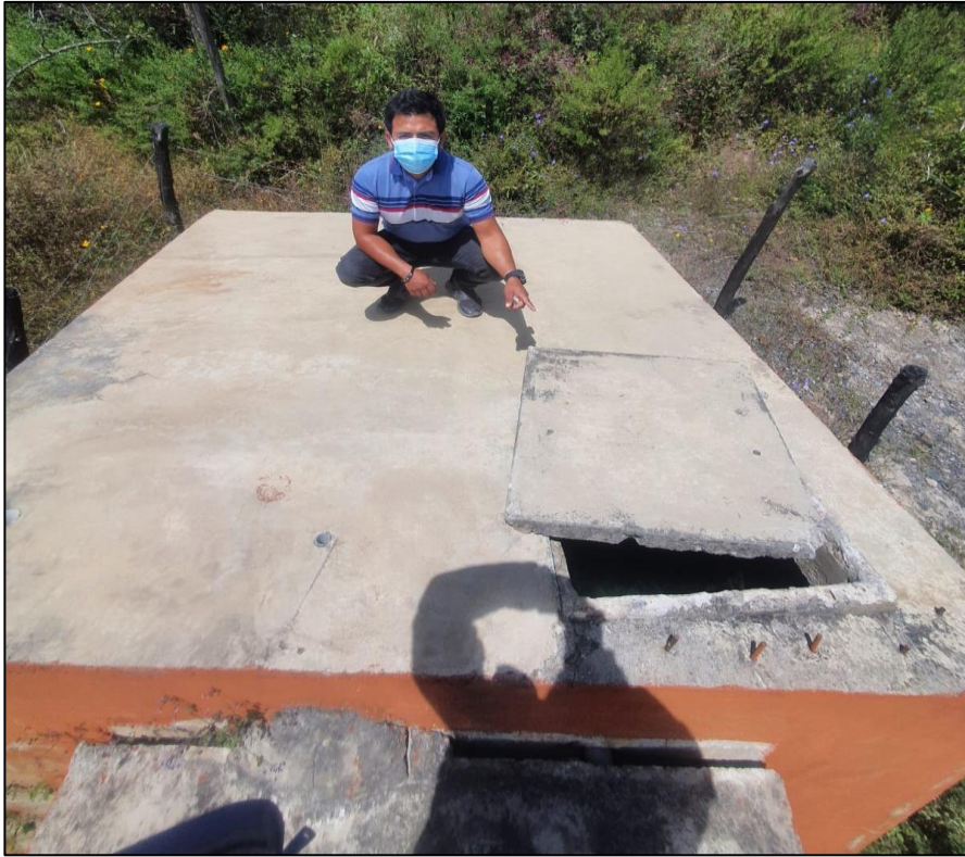
Fotografía 5: Se observa el reservorio existente del caserío de Paccha
