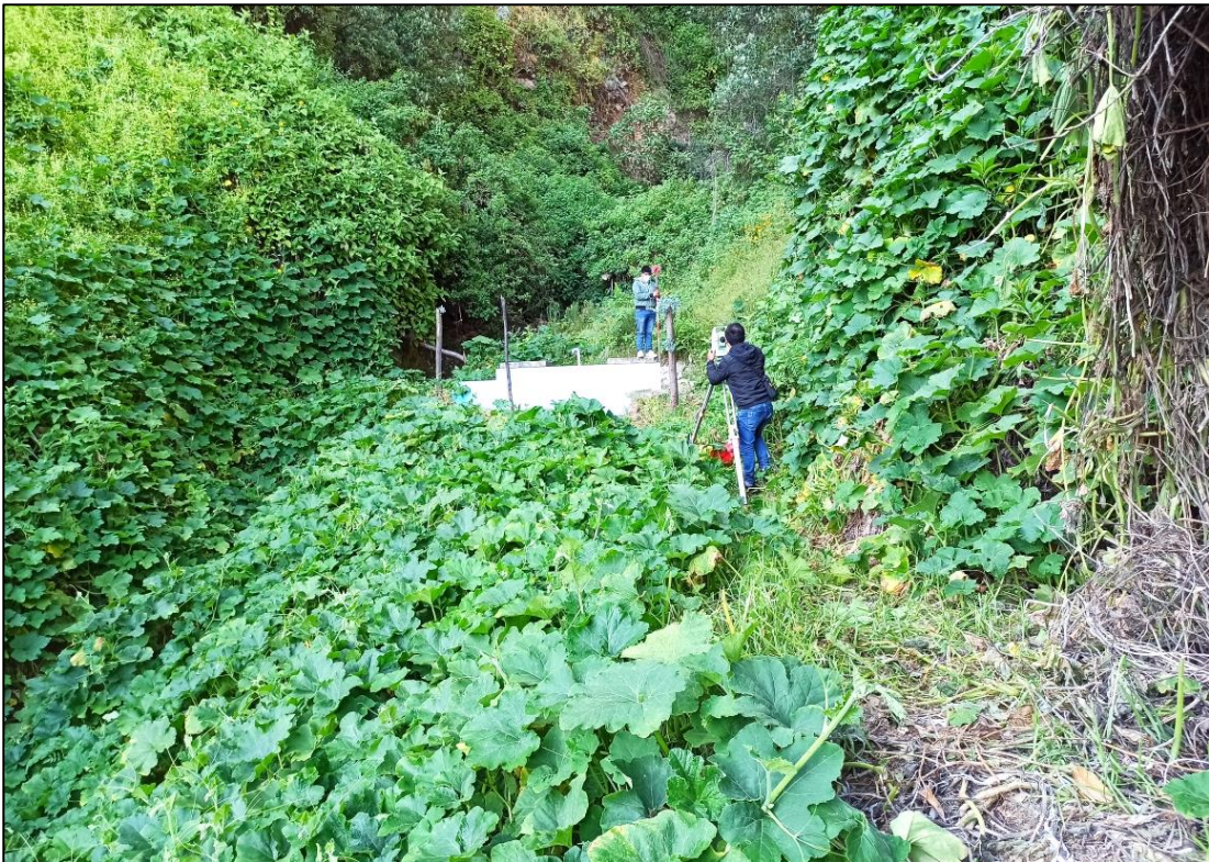
Fotografía 2: Tomando puntos topográficos en la captación del sistema de abastecimiento de agua potable del caserío de Paccha
