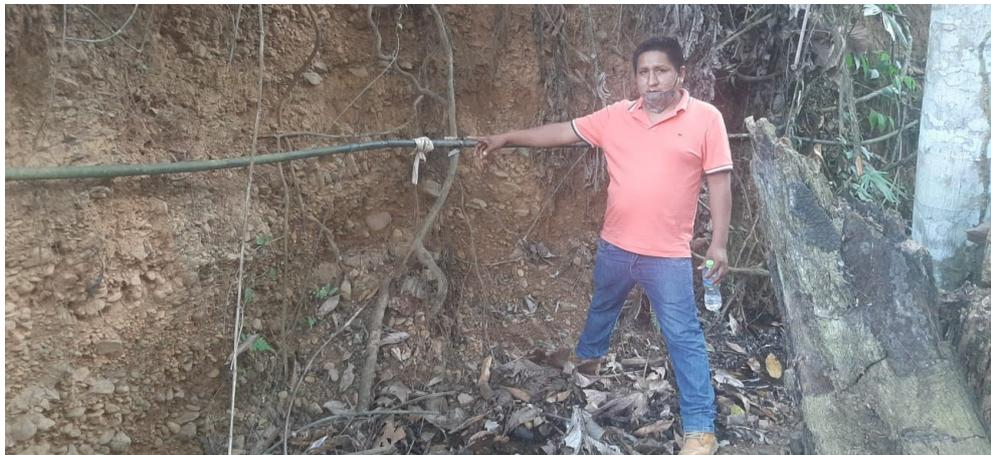
**Figura 4.** Tuberías del sistema existente expuesto y amarrado con jebe
