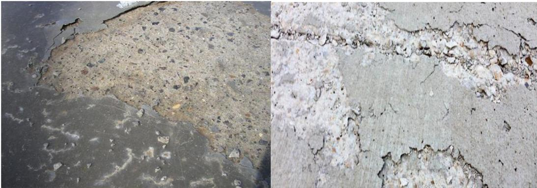
*Figura 27.* Patología por delaminación del concreto.
