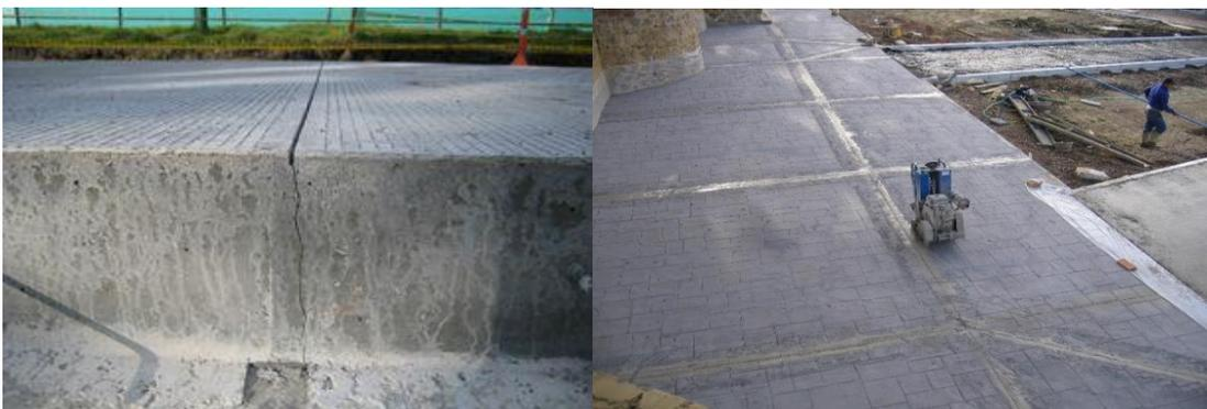
*Figura 30.* Patologías en sello de juntas del concreto.
