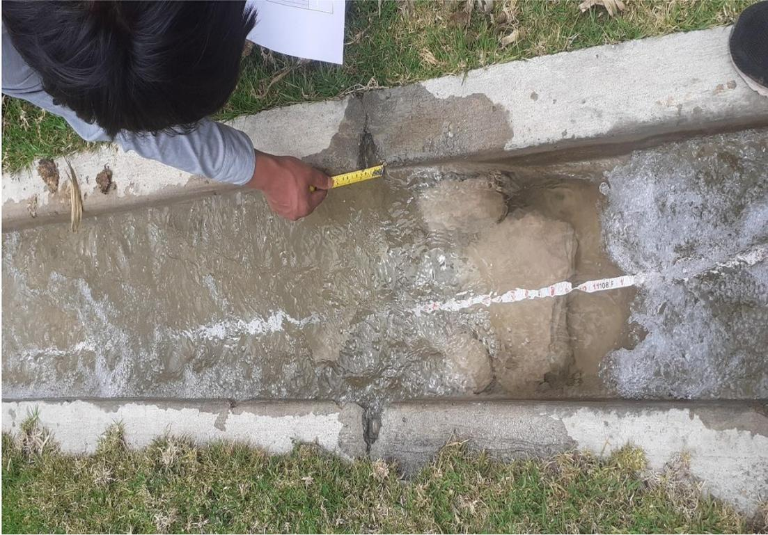
*Figura 48.* Canal de riego Potrero - Medición de patologías y recolección de datos.
