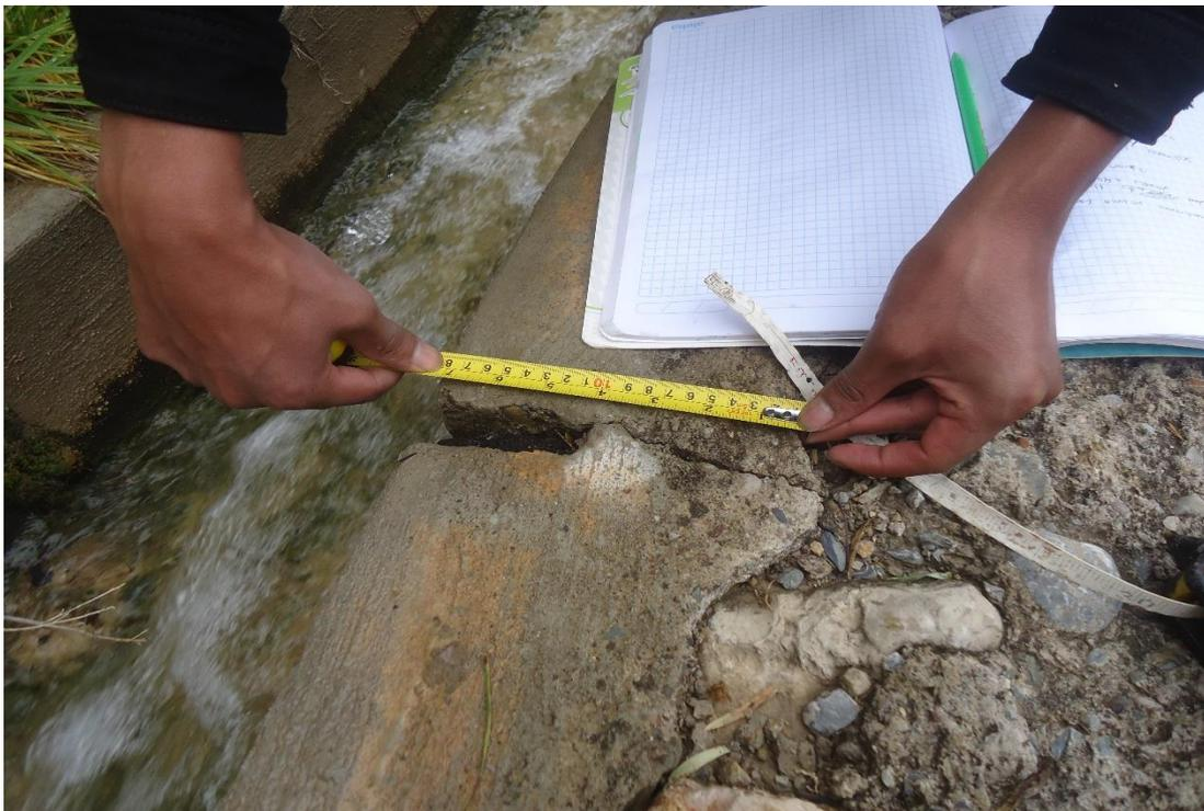
*Figura 41.* Canal de riego Potrero - Medición de patologías.
