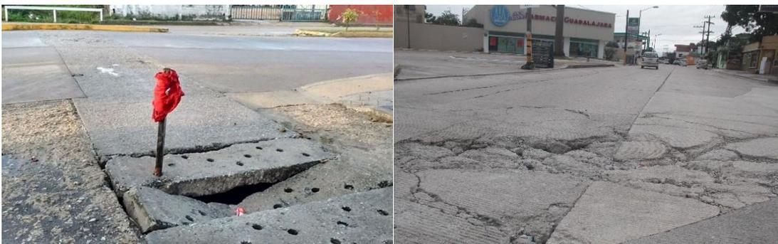
*Figura 28.* Patologías por hundimiento del concreto.
