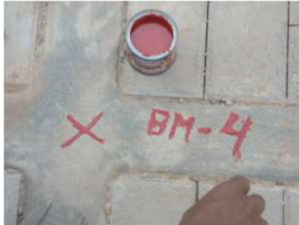
Fotografía N.-04 en la toma se observa el BM-4 dejado en la vereda, señalado con pintura.
