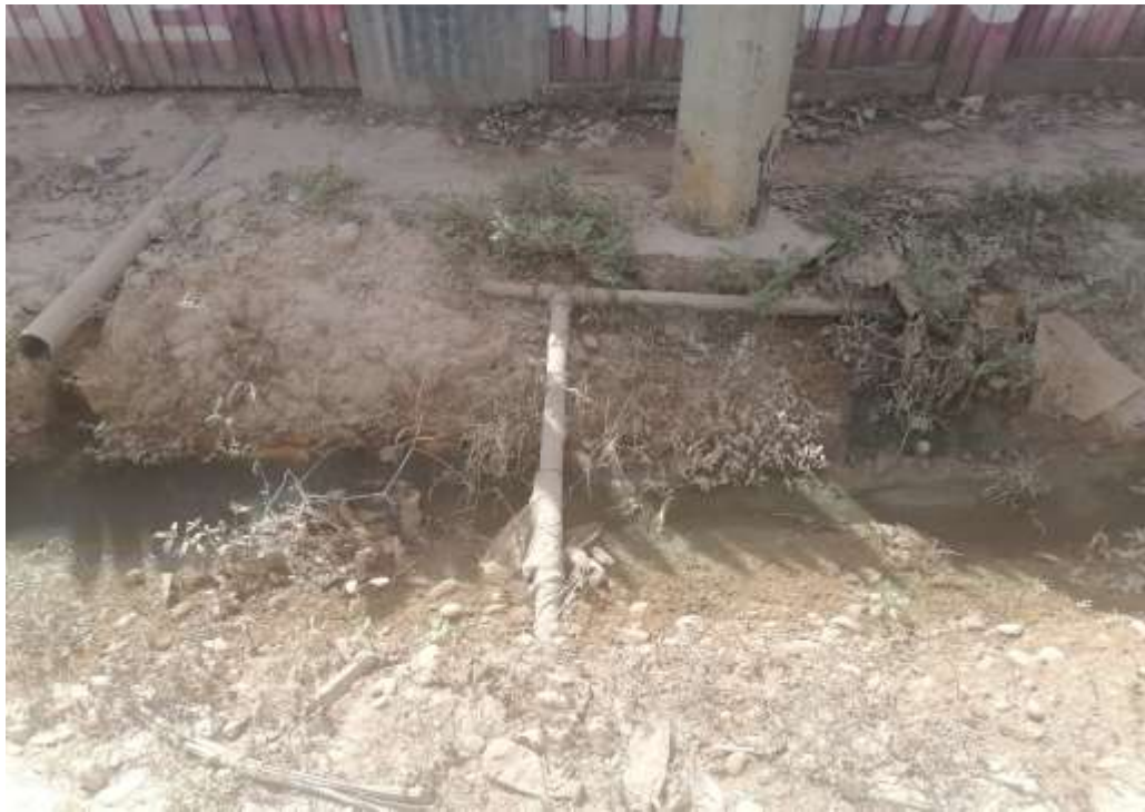
Imagen 31 Tubería expuesto.
