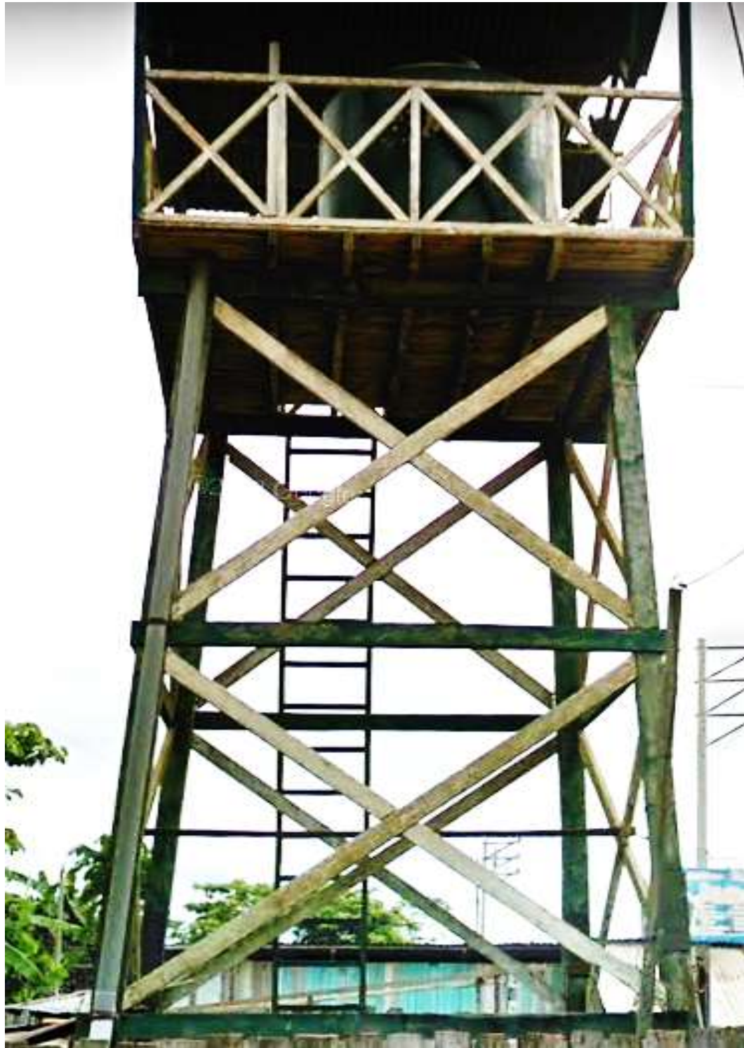
Imagen 23 Línea de aducción en bajante alineado a la columna de la estructura.
