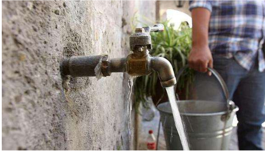
Imagen 14: Cobertura de agua potable
