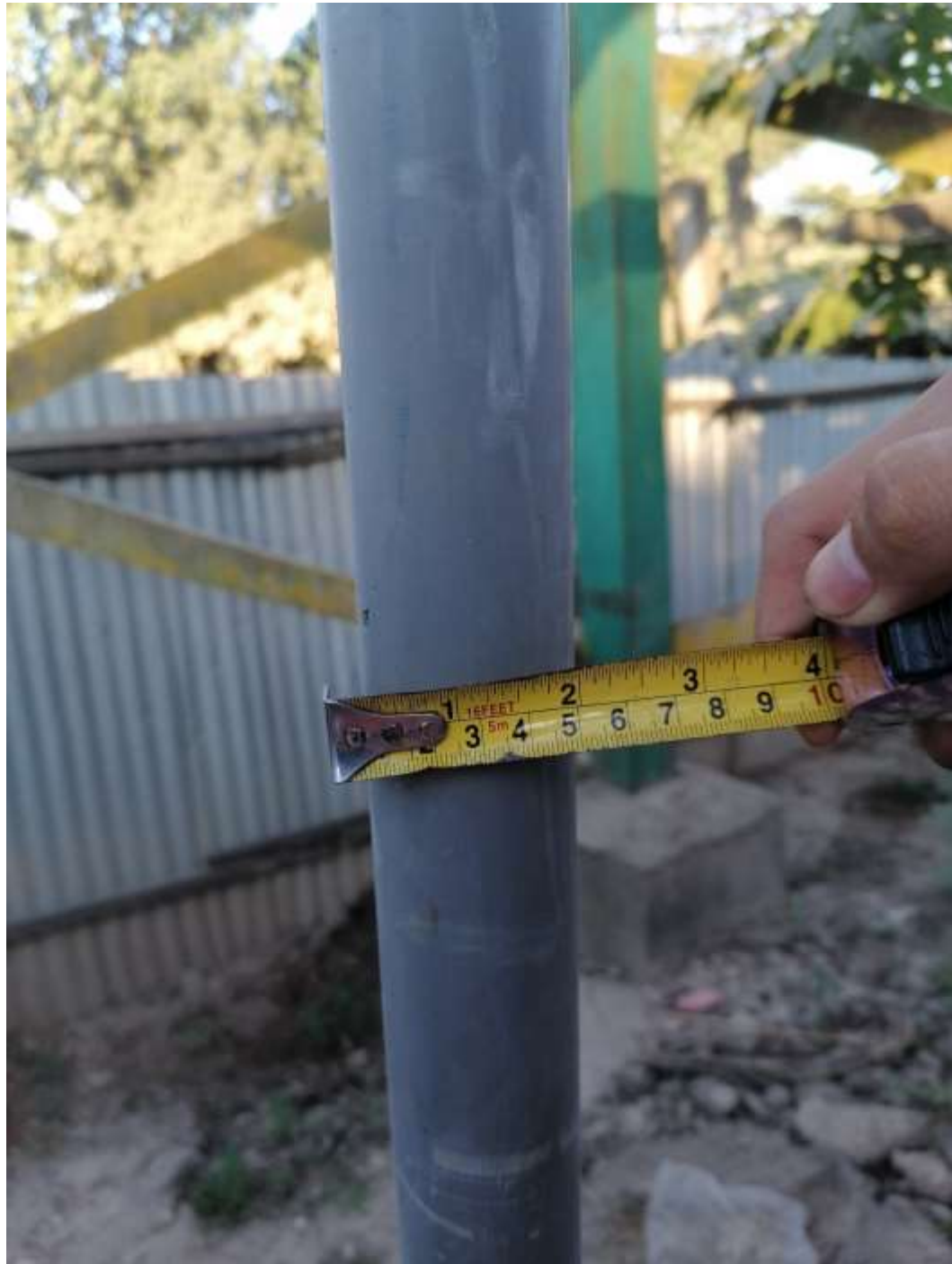
Imagen 20: Línea de impulsión que va conectado desde la boca de la bomba hasta el reservorio.
