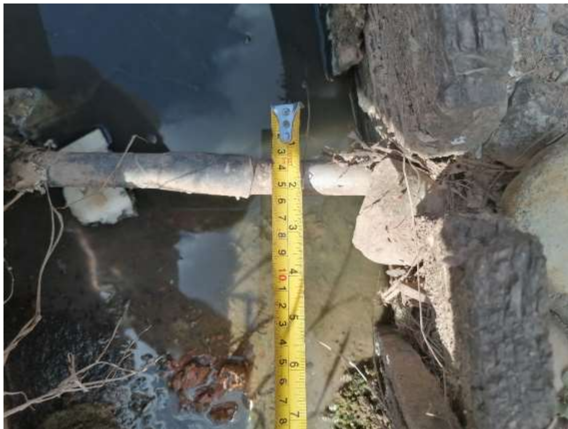
Imagen 29: Conexión domiciliaria tubería de ½”.
