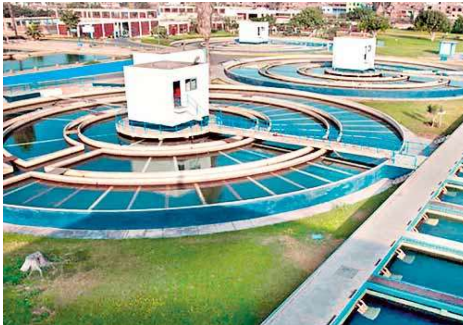
Imagen 15: Planta de tratamiento cantidad de agua.
