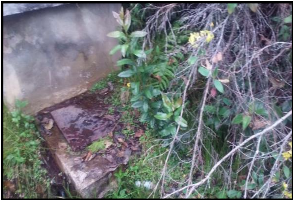
Imagen 01. Captación actual en el caserío de Santa María en malas condiciones y sin cerco perimétrico.
