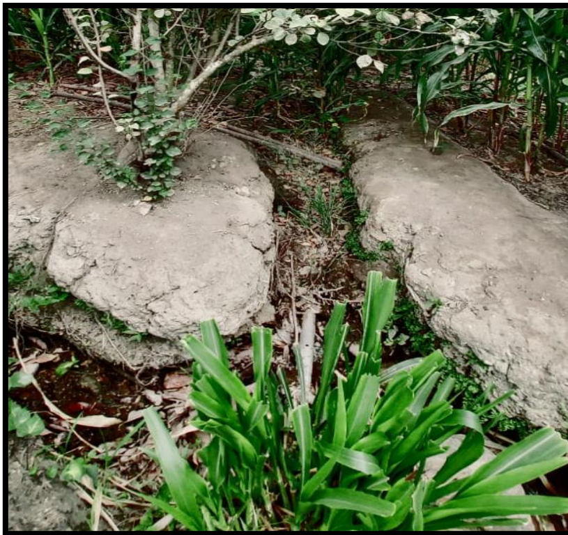
Imagen 14. Tubería de la línea de conducción
