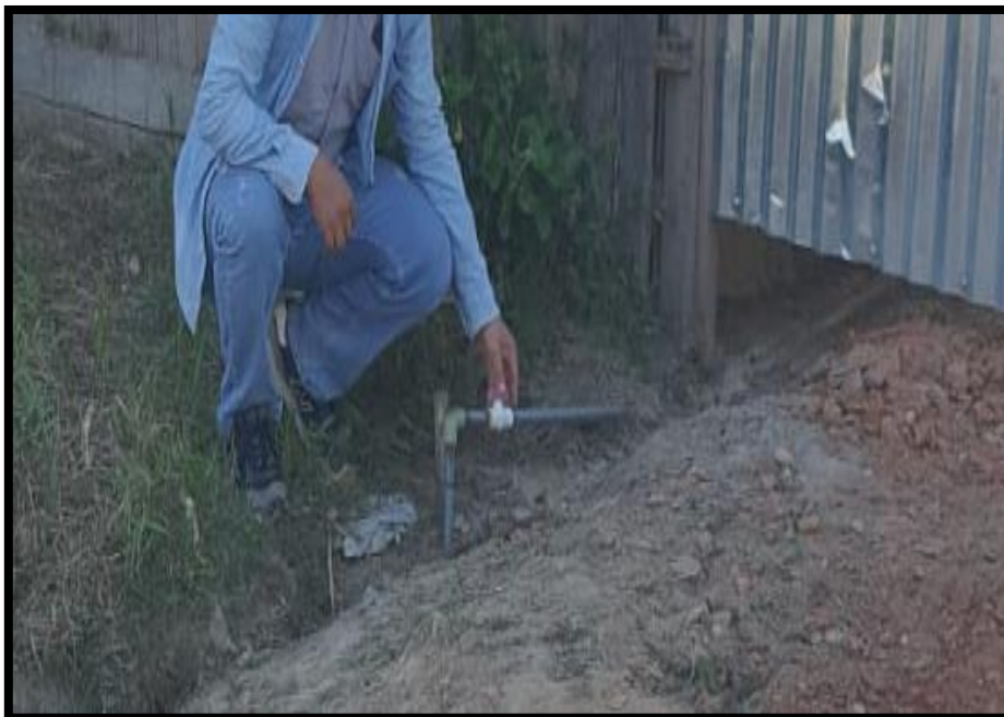
Imagen 16. Conexión entre la red de distribución y la conexión domiciliaria existente.
