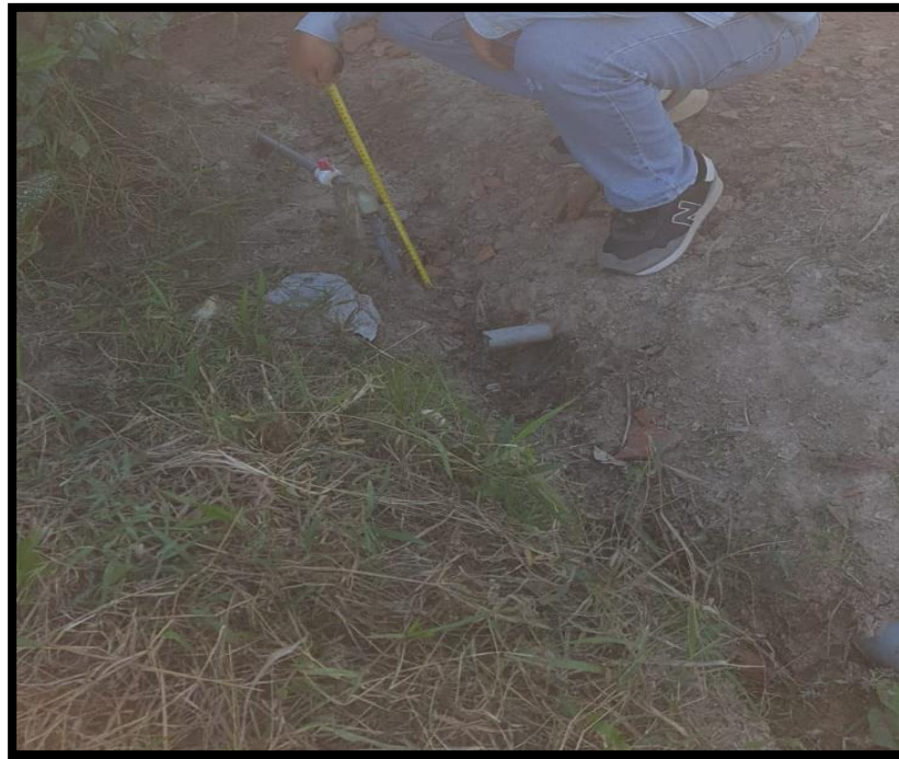
Imagen 09. Red de distribución expuesta a la intemperie (tubería principal)
