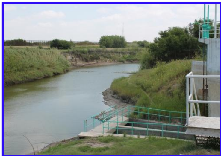
Figura 3. Captación una fuente superficial (río).
