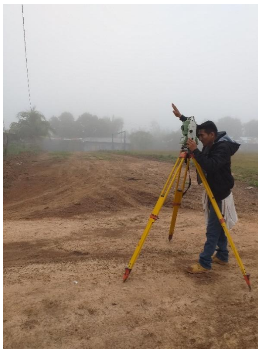
Fotografía 05: ubicación del reservorio de almacenamiento
