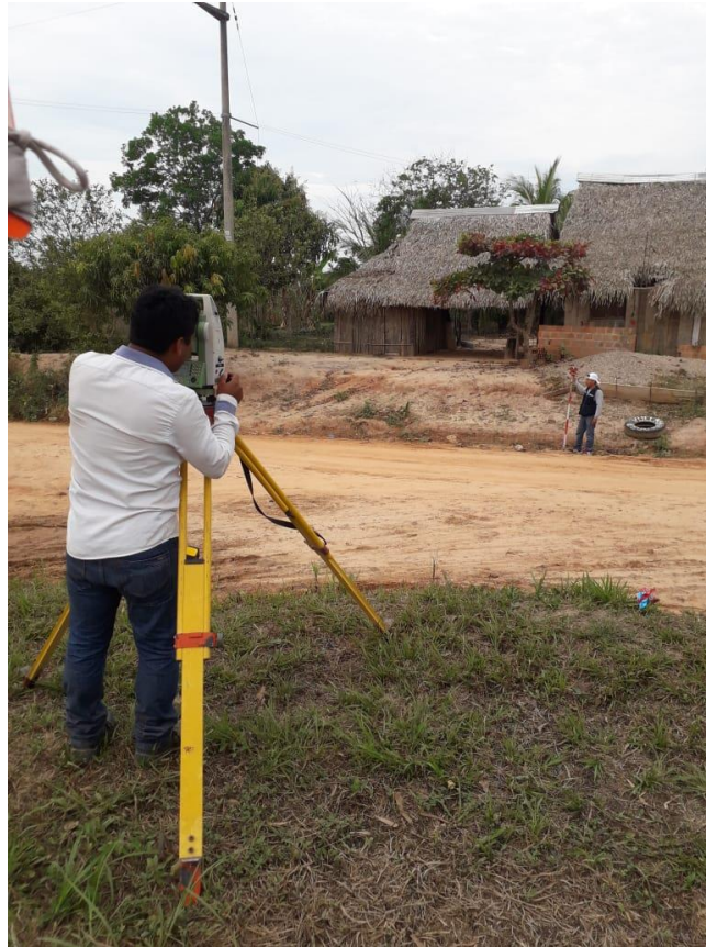
Fotografía 04: Trazo de la línea de aducción
