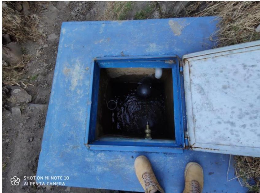
Fotografía 6 estado de la cámara rompe presión tipo 6
