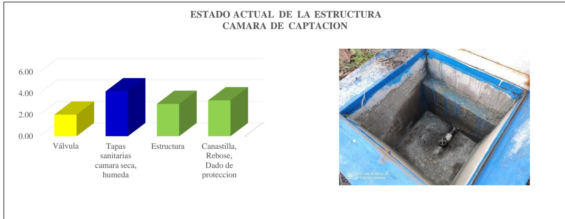
Descripción la cámara de captación se descompone en 3 partes que son la cámara seca donde se encontró las válvula de pase en estado Malo, y con su tapa sanitaria en estado bueno, para la cámara húmeda se tiene que la canastilla de salida, rebose, y el dado de protección se encuentra en estado regular, para las aletas de la captación la estructura se encuentra en estado regular
