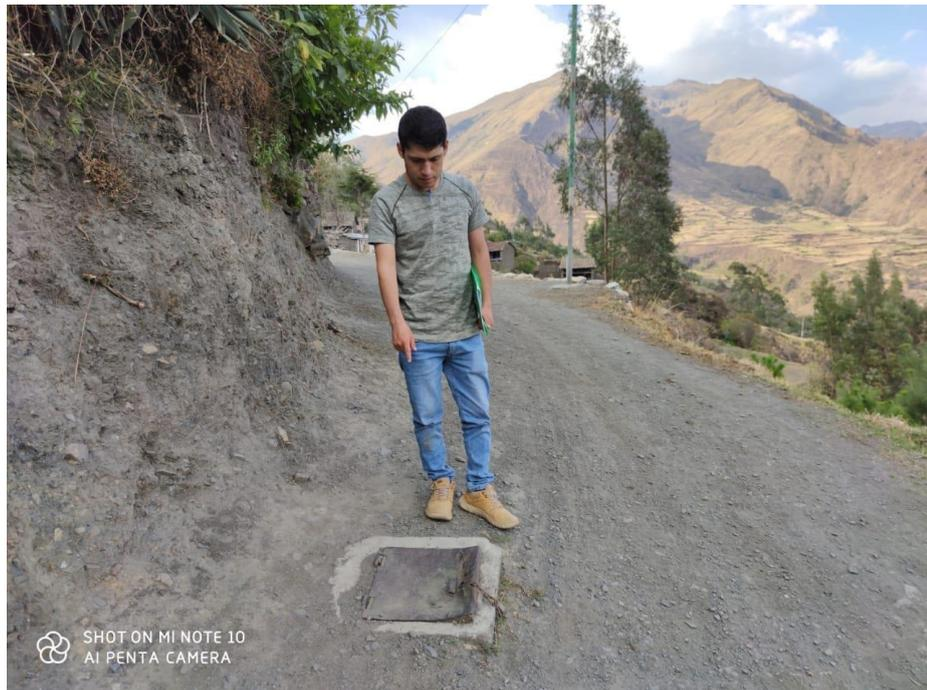
Fotografía 4 válvula de purga de la línea de conducción
