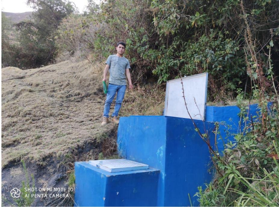
Fotografía 5 cámara de captación sin cerco perimétrico
