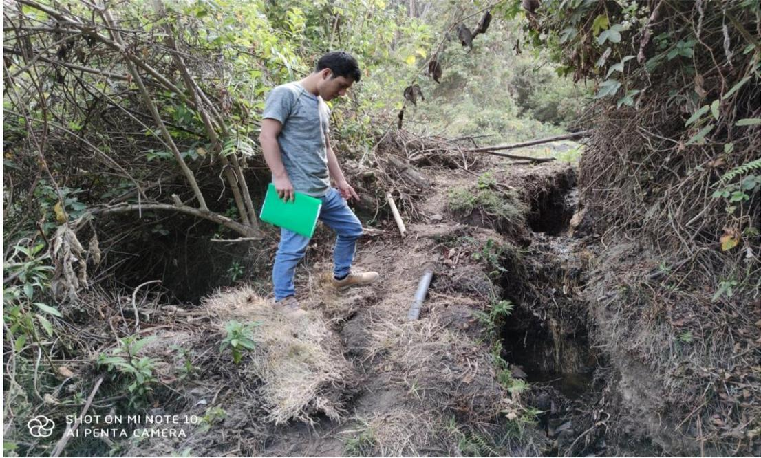
Fotografía 3 tubería expuesta de la línea de conducción
