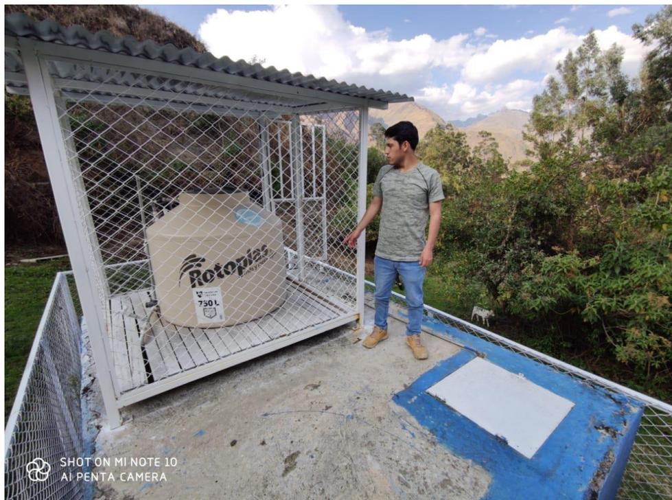
Fotografía 8 sistema de cloración por goteo
