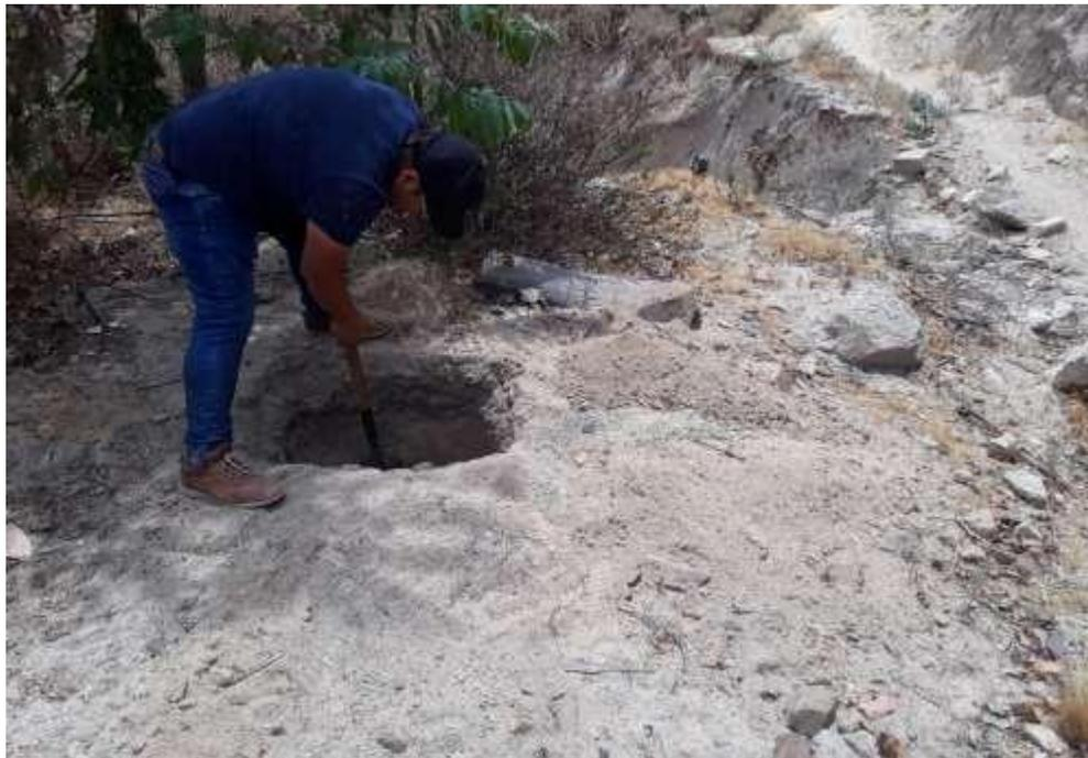
**Fotografía N° 10:** En esta fotografía se muestra excavando de la calicata a una profundidad de 1.5m donde estará ubicado el reservorio de almacenamiento.
