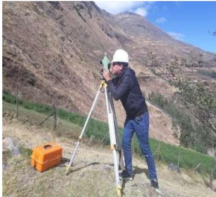
**Fotografía N° 6:** En esta fotografía se realizó la topografía en el tramo donde se planteó la captación hasta llegar al punto del reservorio.
