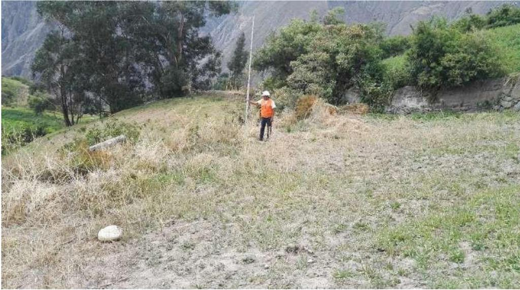
**Fotografía N° 7:** En esta fotografía se realizó la topografía en el punto donde se ubicara el reservorio donde almacenara agua distribuir al centro poblado Culcubamba.
