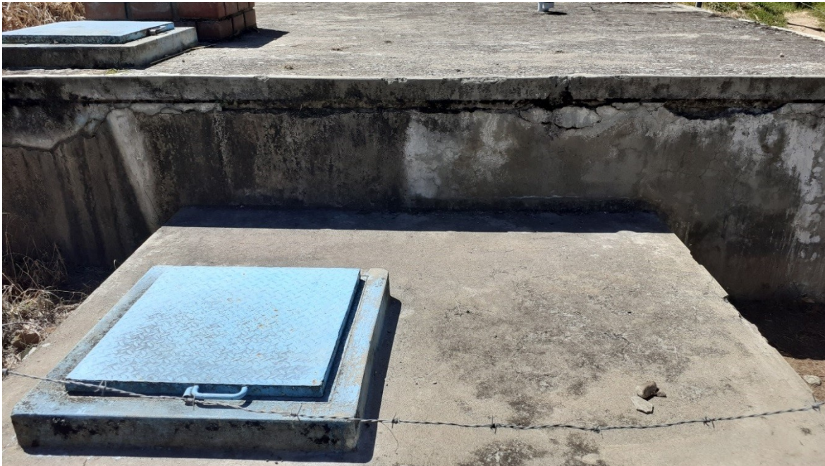
Fotografía N° 08: Fotografía del Reservorio se visualiza la patología descascaramiento en muro sur de la caseta de válvulas.
