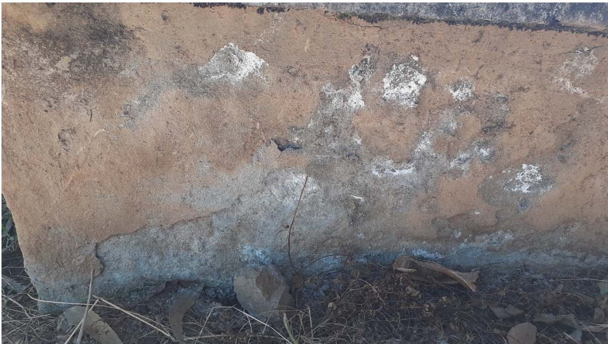
Fotografía N° 08: Fotografía del Reservorio se visualiza la patología descascaramiento en muro sur de la caseta de válvulas.
