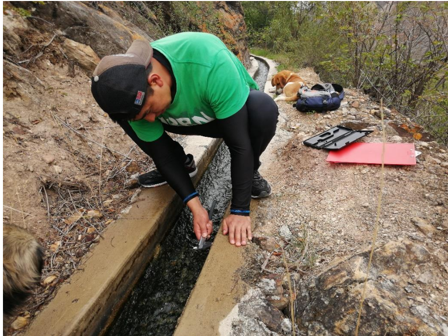
Fotografía 06 Vista de la medición de aberturas con el vernier
