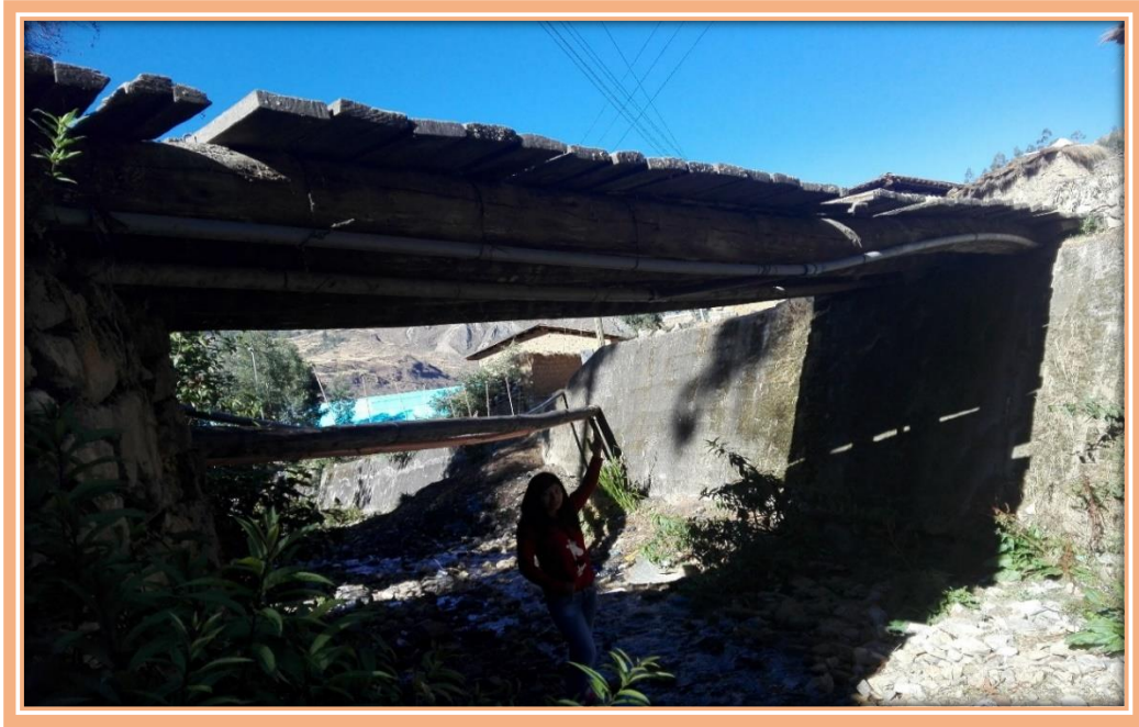
Figura 28: Línea de conducción expuesta
