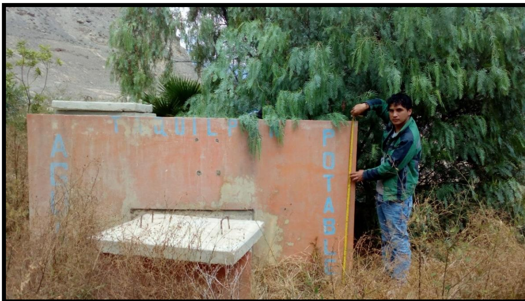
Fotografía N° 06: Reservorio de agua potable actual del caserío de Taquilpon.
