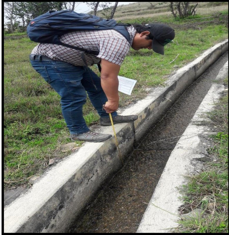
Fotografía 02 tomando medidas del muro izquierdo del canal
