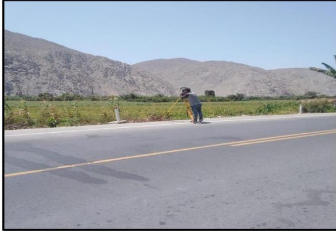
**Imagen N° 03:** Topografía para línea de conducción
