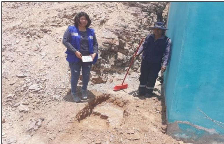
*Figura N°31: Reservorio N°01 –Presenta salitre en la parte baja*
