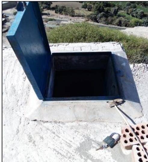
*Figura N°29: Reservorio N°01 –Tapa Metálica*
