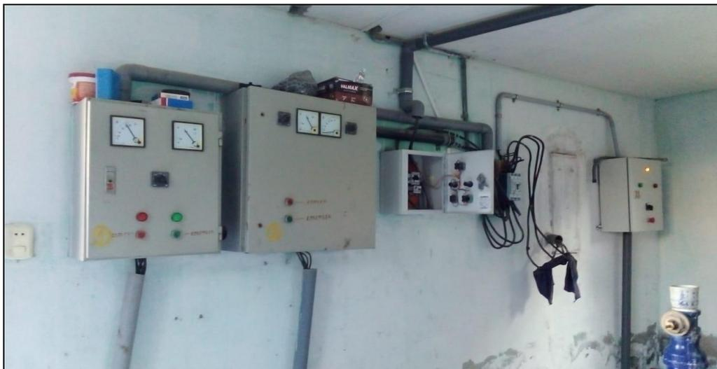
*Figura N°27: Estación de bombeo – Interruptores con tablero de protección*
