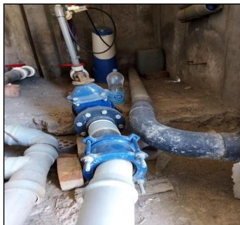
*Figura N°39: Reservorio N°02 – Se observa las válvulas de salida*
