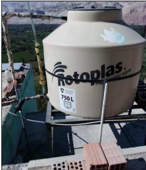
*Figura N°30: Reservorio N°01 –Sistema de cloración por goteo*
