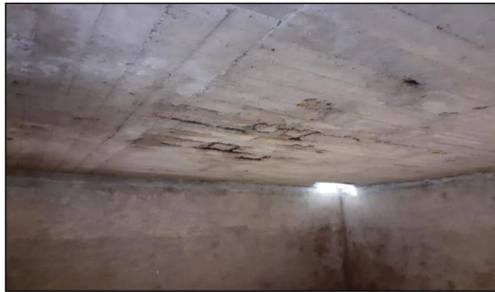
*Figura N°35: Reservorio N°02 – se visualiza el acero del techo*
