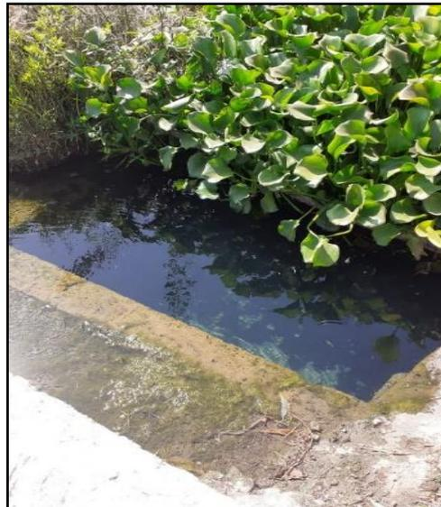
*Figura N°23: Captación cubierto de maleza*
