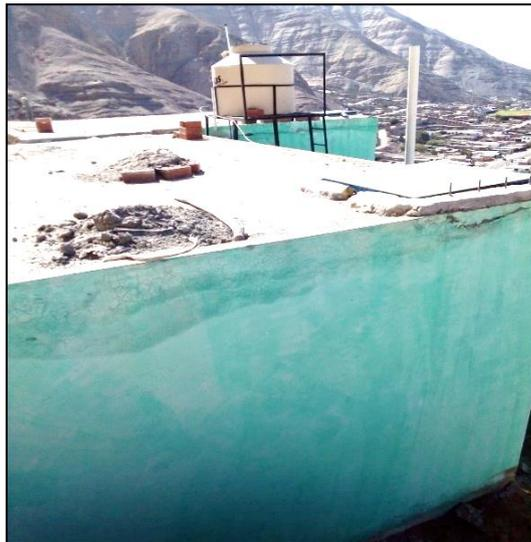
*Figura N°28: Reservorio N°01 –Presenta filtraciones al exterior*
