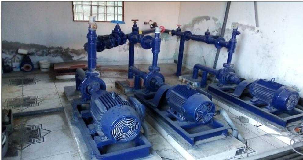
*Figura N°26: Estación de bombeo – se observa las bombas de 30 HP*
