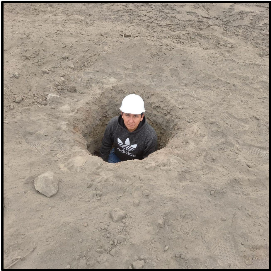
Imagen N°4: Podemos apreciar la toma de muestra de la Calicata para su ensayo de mecánica de suelos.
