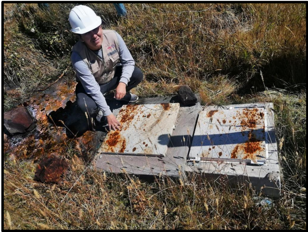
Imagen 1 Captación por manantial tipo ladera (manantial quillque)
