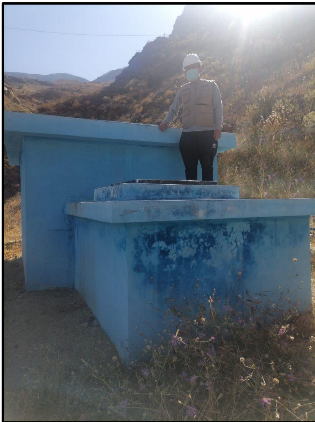
Imagen N°3: Reservorio de almacenamiento de agua apoyado rectangular de la localidad Acclahuin, La Libertad, Huaraz, Áncash
