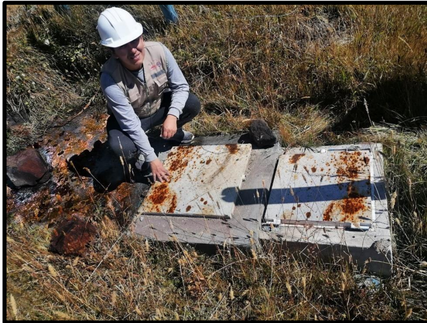
Imagen N°2: Captación de ladera del manantial Quillque de la localidad Acllahuain La Libertad, Huaraz, Áncash
