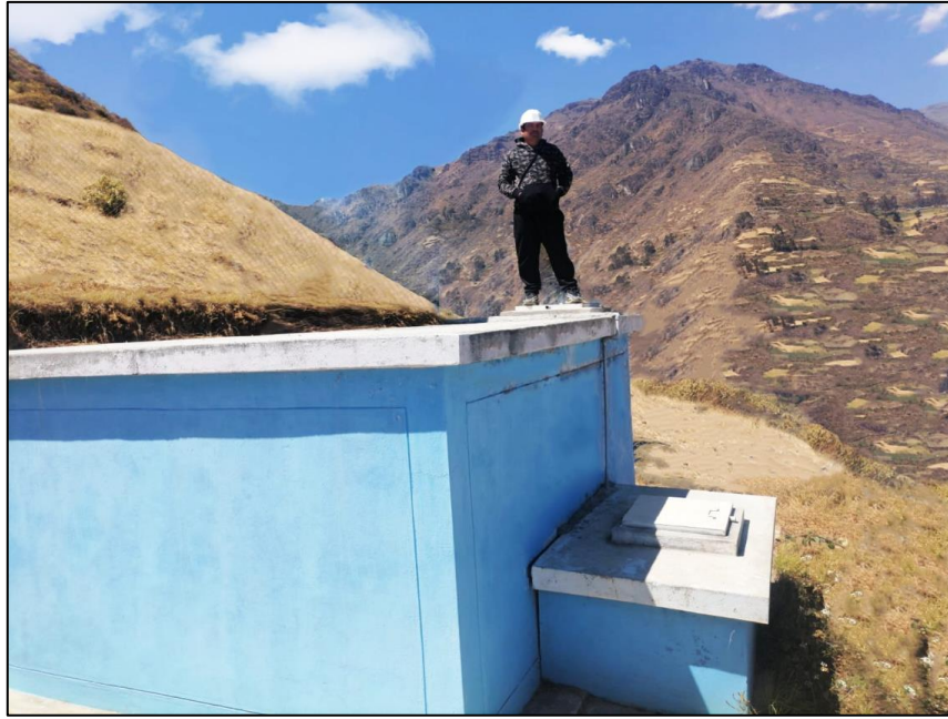
Imágen 6 Reservorio apoyado rectangular
