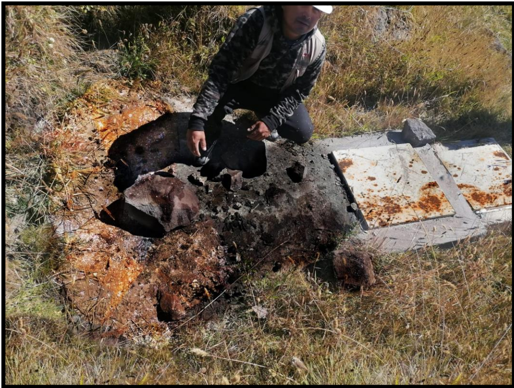
Imágen 1 Obra de captación por manantial (Chaquilma Alta) tipo ladera y concentrado
