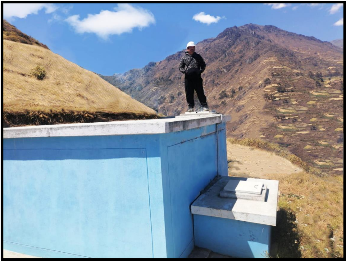
Imágen 3 Reservorio apoyado de 10 m 3
