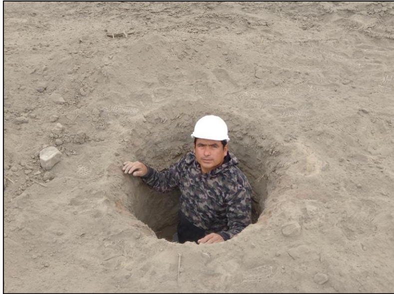
Imágen 8 Calicata para ensayo de mecánica de suelos
