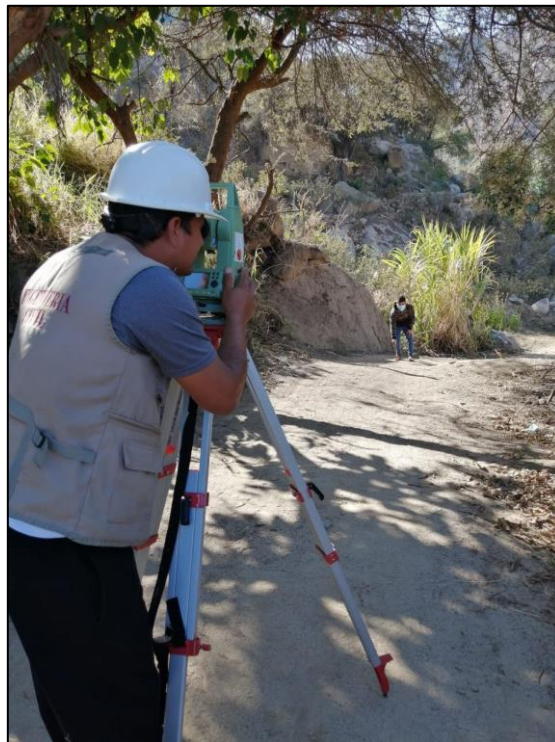
Imágen 7 Levantamiento topográfico
