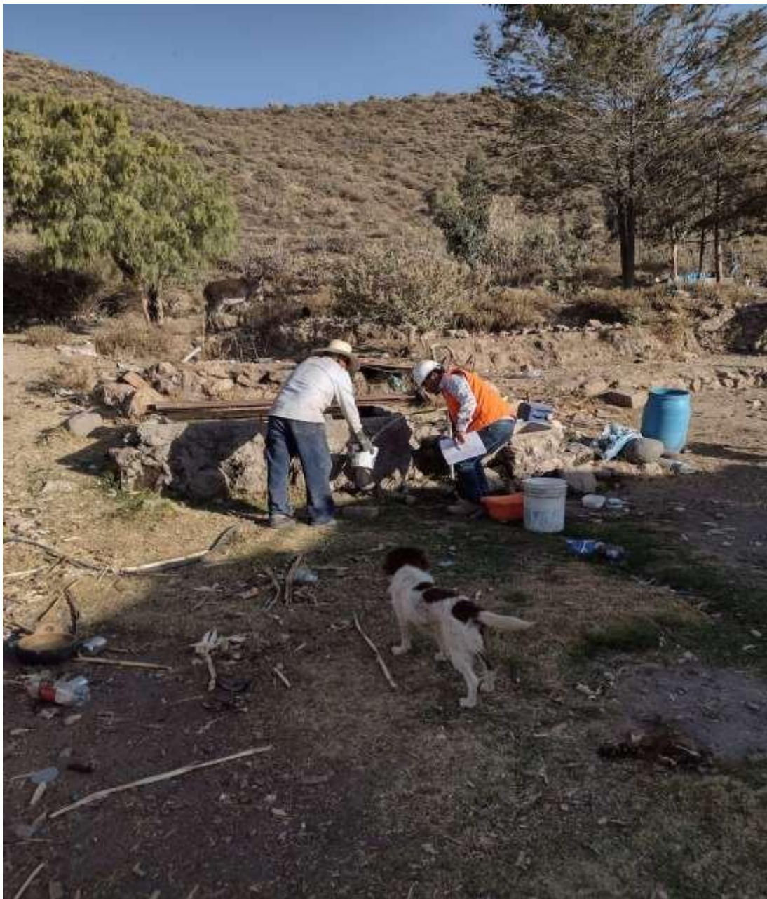
Fotografía 03: fuente de abastecimiento actual colapsado
