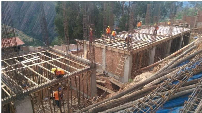
**Grafico 5:** Acero de Refuerzo en Columnas de C° Armado.
