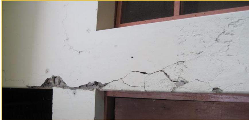
**Grafico 35:** Figuración y Agrietamiento por asentamiento de la estructura.
