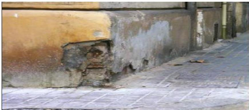
**Grafico 24:** Ataque por físico por exposición a humedad atmosférica se ha producido erosión mecánica con pérdidas considerable de material.
