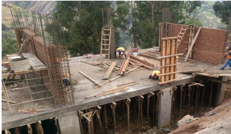
**Grafico 4:** Estructura – Columnas de Concreto Armado.
