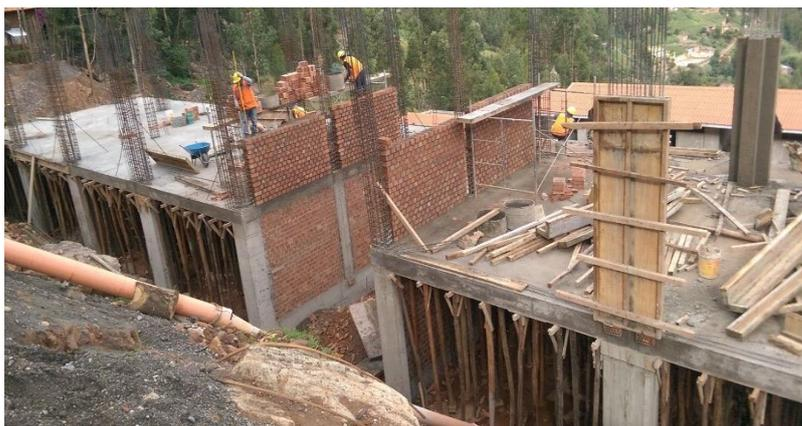
**Grafico 3:** Elementos de Concreto Armado y Albañilería.
