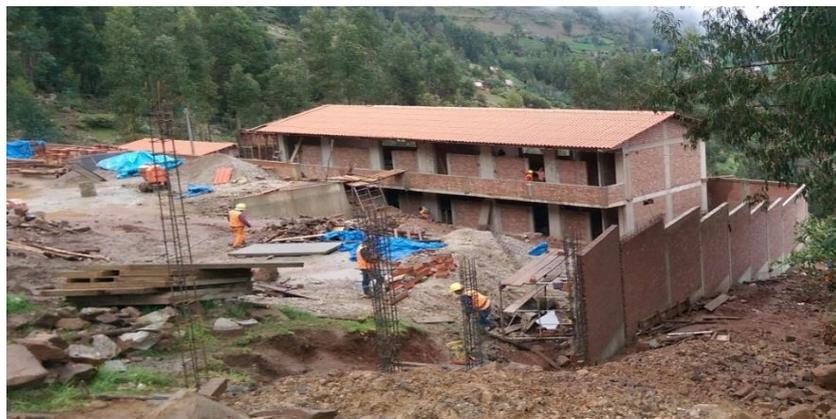
**Grafico 10:** Edificación Construida mediante Sistema Confinado.
