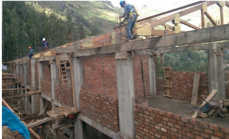
**Grafico 13:** Vigas de concreto armado.
