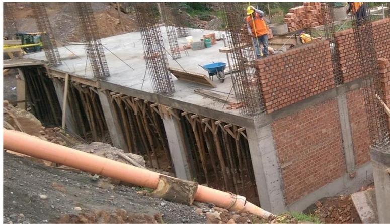
**Grafico 18:** Elementos de una edificación de Albañilería Confinada.
