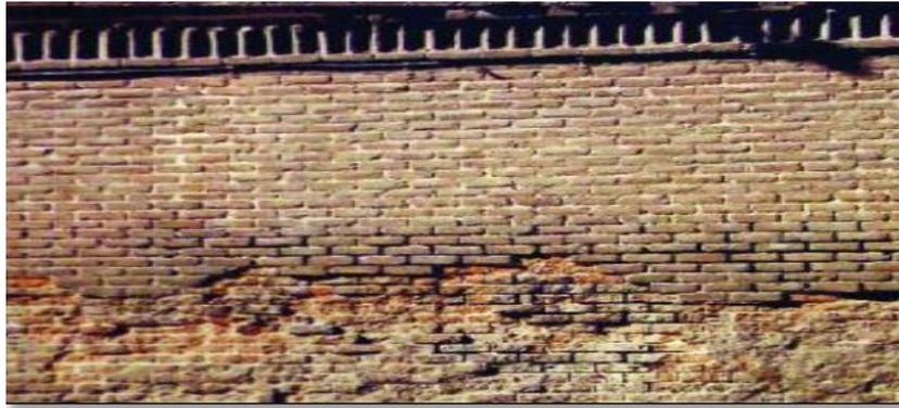
**Grafico 32:** Efecto devastador del ciclo hielo – deshielo en muros de ladrillo.
