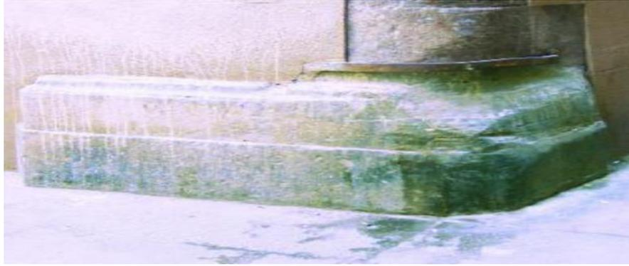
**Grafico 34:** Ataque biológico a estructura de concreto por biocapas.
