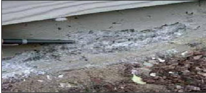
**Grafico 23:** Ataque por Físico a edificación por Humedad de Infiltración.
