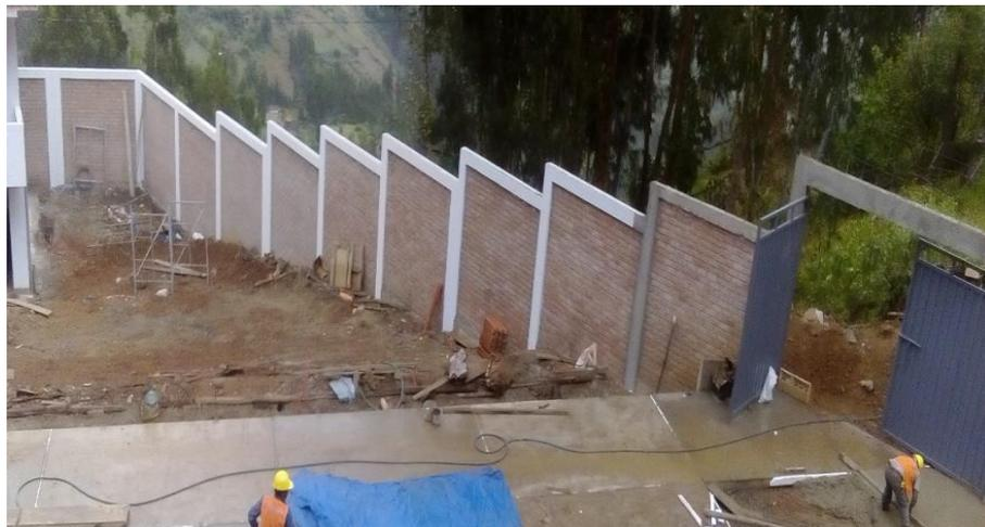
**Grafico 15:** Viga Confinada de Concreto Armado en Cerco Perimétrico.
