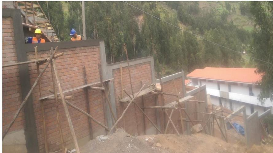
**Grafico 11:** Elementos de Cierre de Cerco Perimétrico. Aplicado Mediante Sistema Confinado.
