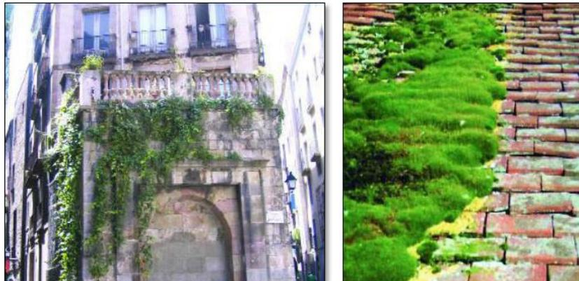
**Grafico 33:** Presencia de vegetacion en edificaciones, deteriorando las juntas de mortero, dejando piezas sueltas y exponiendo el sulfato a humedad y erosiones.
