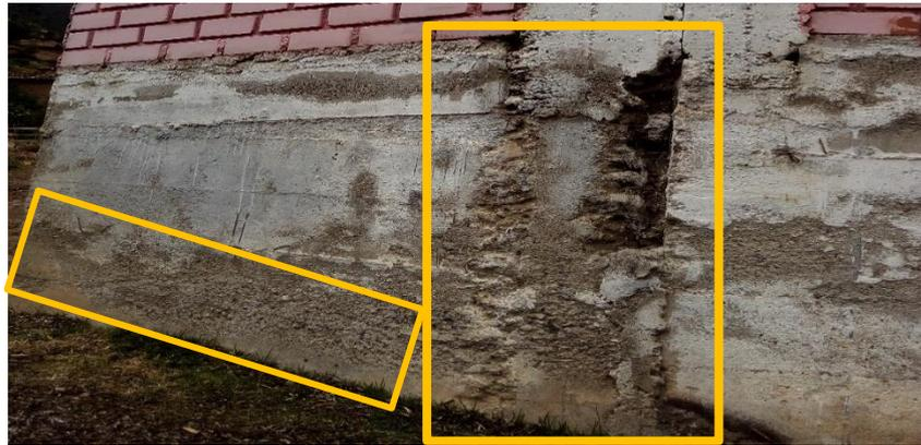
**Grafico 36:** Erosión en sobre cimientado armado y columna.
