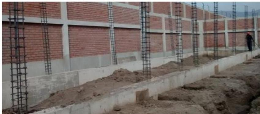
*Grafico 16:* Estructura – Sobre Cimiento de Concreto Armado.
