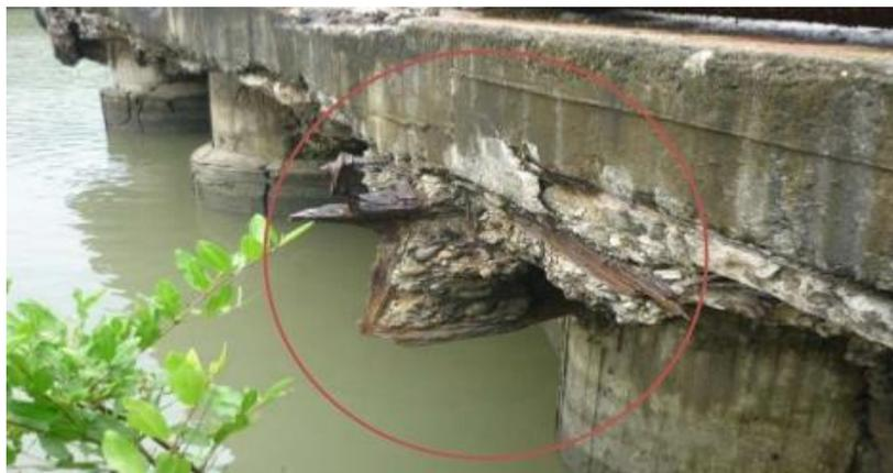
**Grafico 25:** Ataque químico por contacto directo con agua de mar (ataque por cloruros, sulfatos, ataque de la combinación de carbonatación más iones de cloruro).
