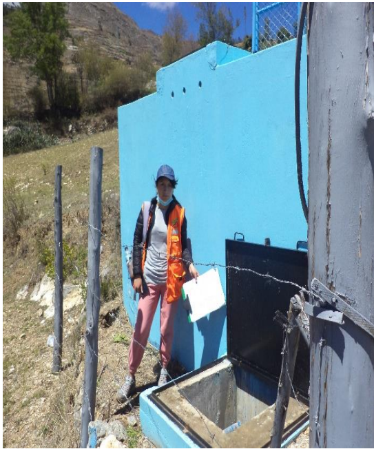
Imagen N° 28: Estructura del reservorio
