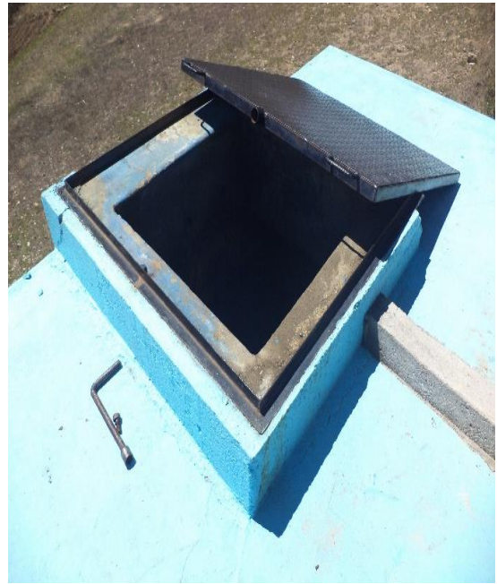
Imagen N° 29: Tapa sanitaria del reservorio
