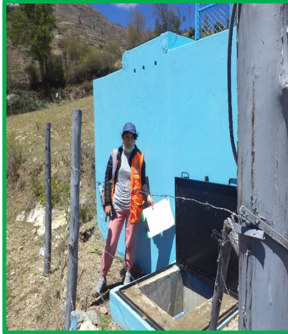
Estructura del reservorio
