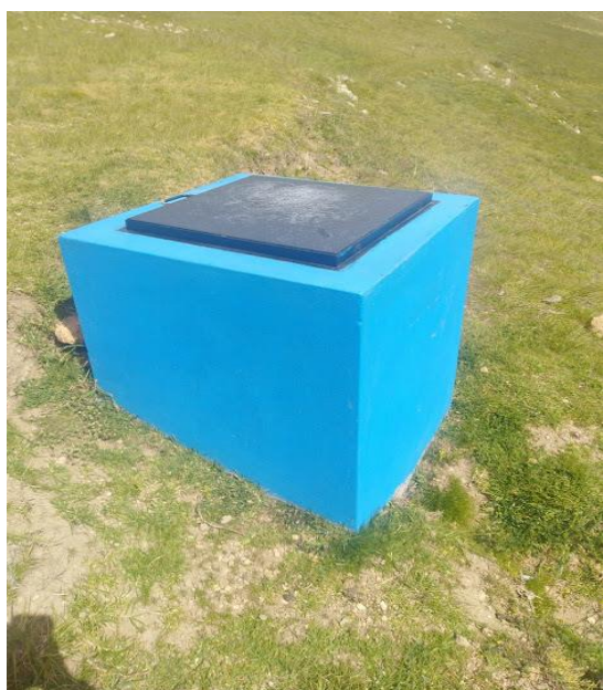
Imagen N° 26: CRP VII en buenas condiciones
