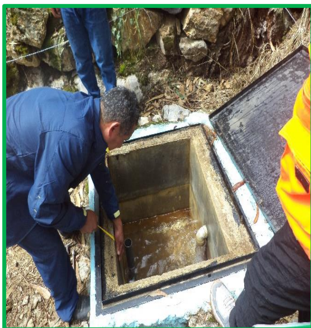
Interior de la captación
