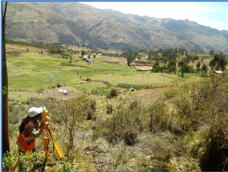
Figura 06: Ubicación para la lectura de puntos del sistema de agua potable.
