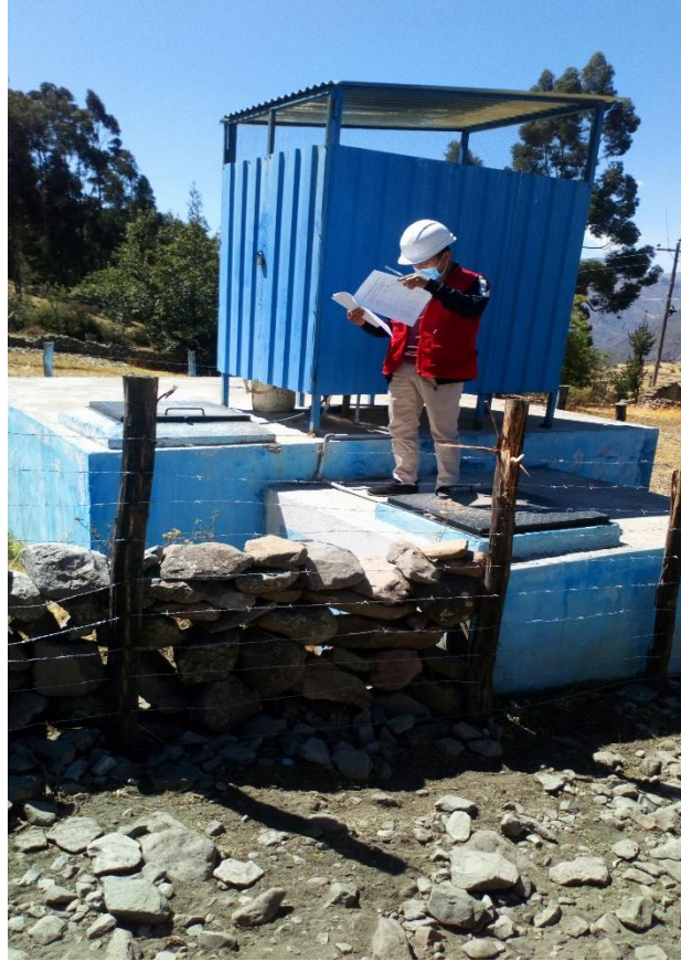
Fotografía 9: llenado de la ficha de evaluación del reservorio.
