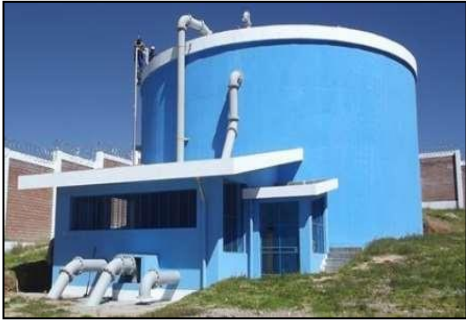
Ilustración 14. Reservorio apoyado
