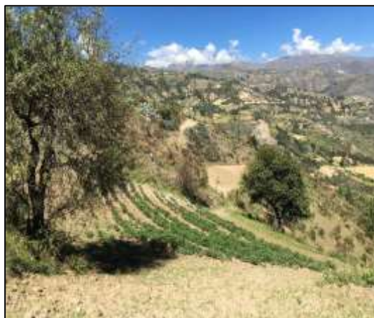
Fotografía 3: Línea de conducción
