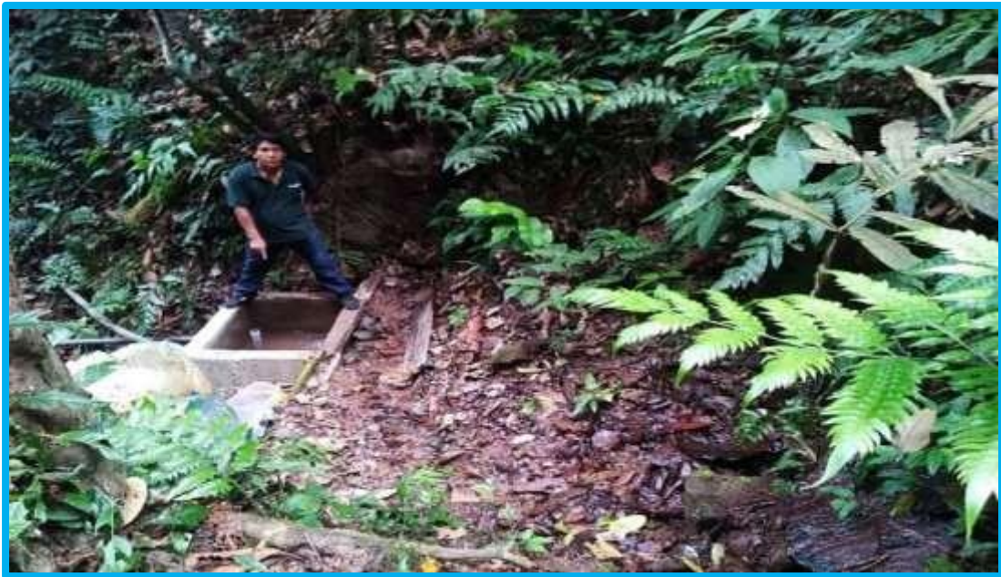
Imagen 01. Captación actual en el centro poblado Primero de Mayo en malas condiciones y sin cerco perimétrico
