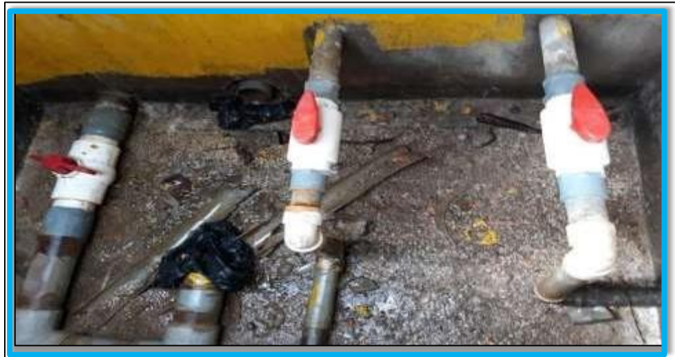
Imagen 06. Accesorios de la caseta de válvulas den malas condiciones
