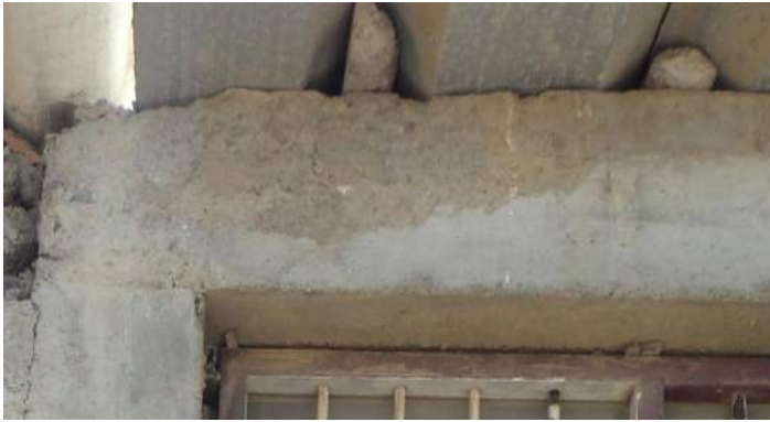
Figura 116: Fotografía donde se observa la patología de Desintegración
