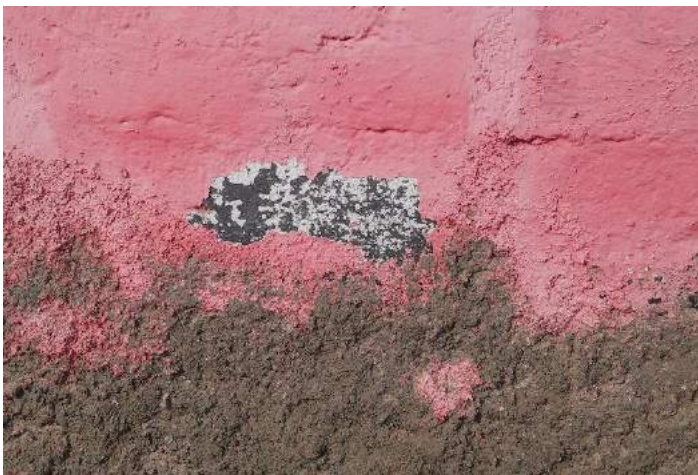
Figura 115: Fotografía donde se observa la patología de Delaminación
