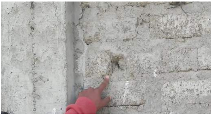
Figura 114: Fotografía donde se observa la patología de Cráteres
