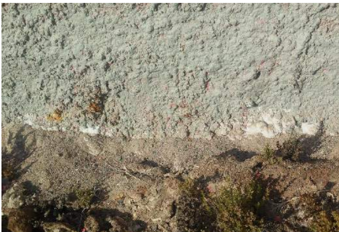
Figura 117: Fotografía donde se observa la patología de Eflorescencia
