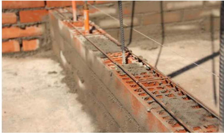
Figura 05. Imagen de albañilería armada
