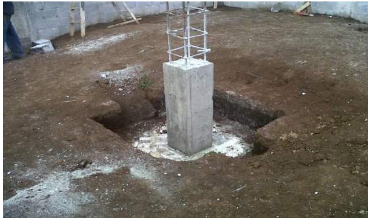
Figura 02. Imagen de columna
