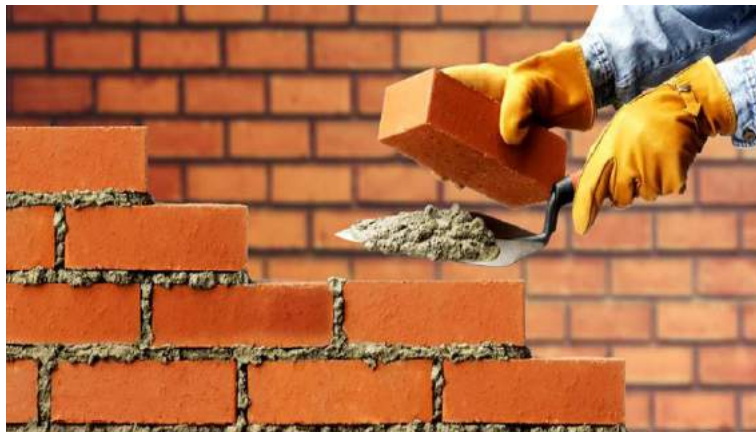
Figura 04. Imagen de albañilería o mampostería
