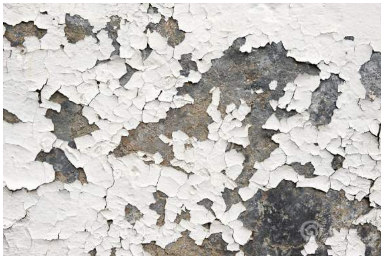
Figura 16. Imagen de escamas en pared
