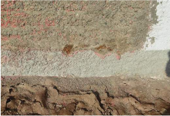
Figura 113: Fotografía donde se observa la patología de Corrosión
