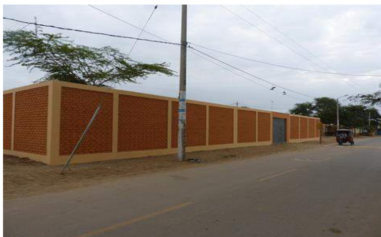
Figura 08. Imagen de cerco perimétrico
