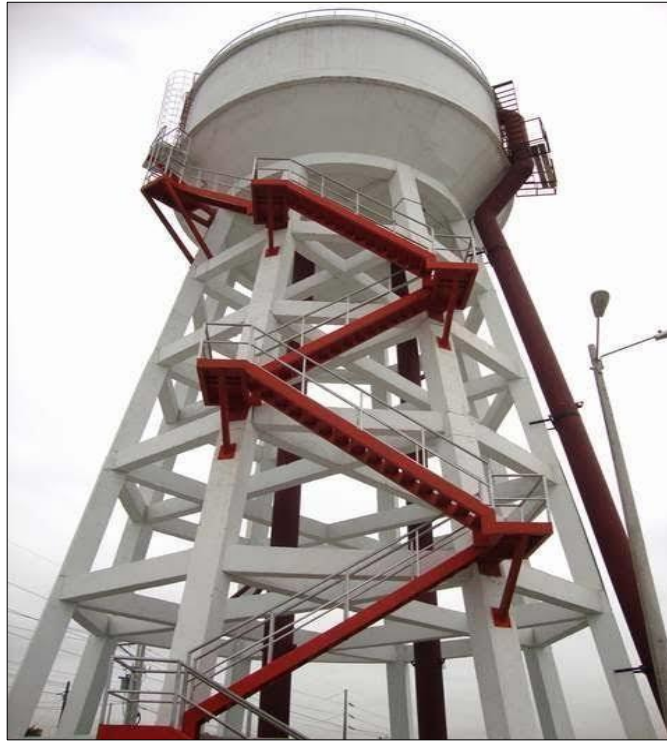
se observa el reservorio elevado existente “R-1” de 50 m 3 de capacidad, de la localidad de Providencia.
