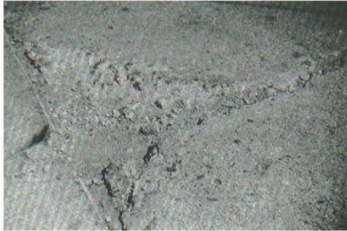
**Figura 20:** Descascaramiento de esquina de alta severidad.
