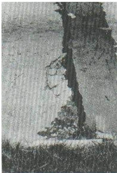
**Figura 4:** Blowup / Buckling de baja severidad
