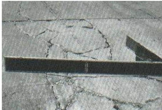
*Figura 16:* Punzonamiento de alta severidad.
