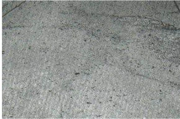
**Figura 06:** Grieta de durabilidad de alta severidad.
