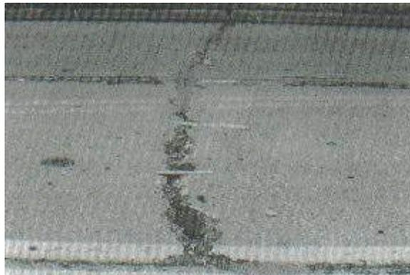
**Figura 10:** Grietas lineales de alta severidad en losa de concreto simple.
