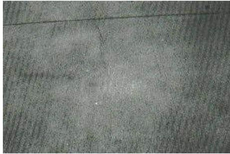
*Figura 19:* Grietas de retracción.
