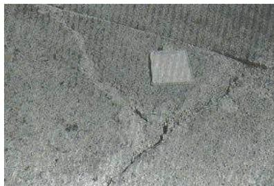
**Figura 5:** Grieta de esquina de alta severidad.
