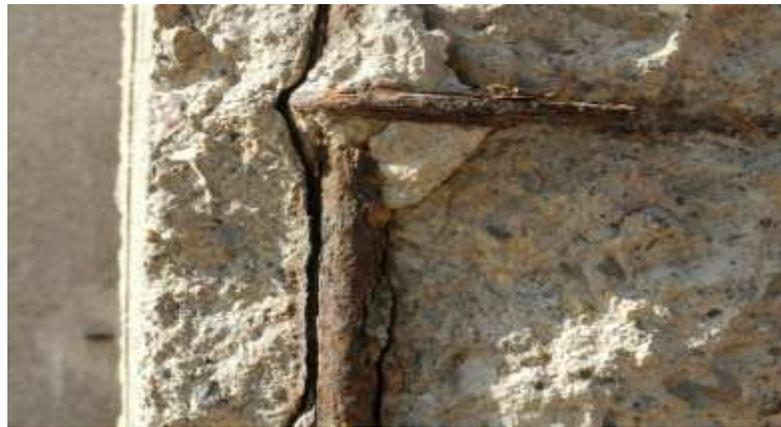
**Imagen 16** Corrosión de Armadura
