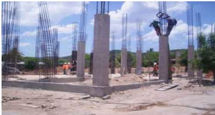
**Imagen 08** Columnas de Concreto Armado
