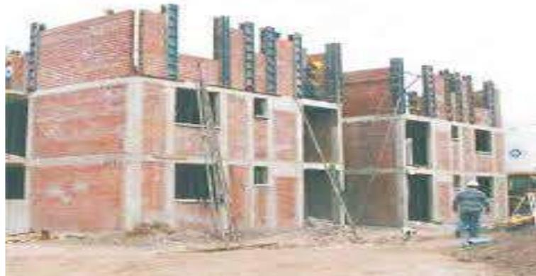
**Imagen 03** Albañilería Confinada
