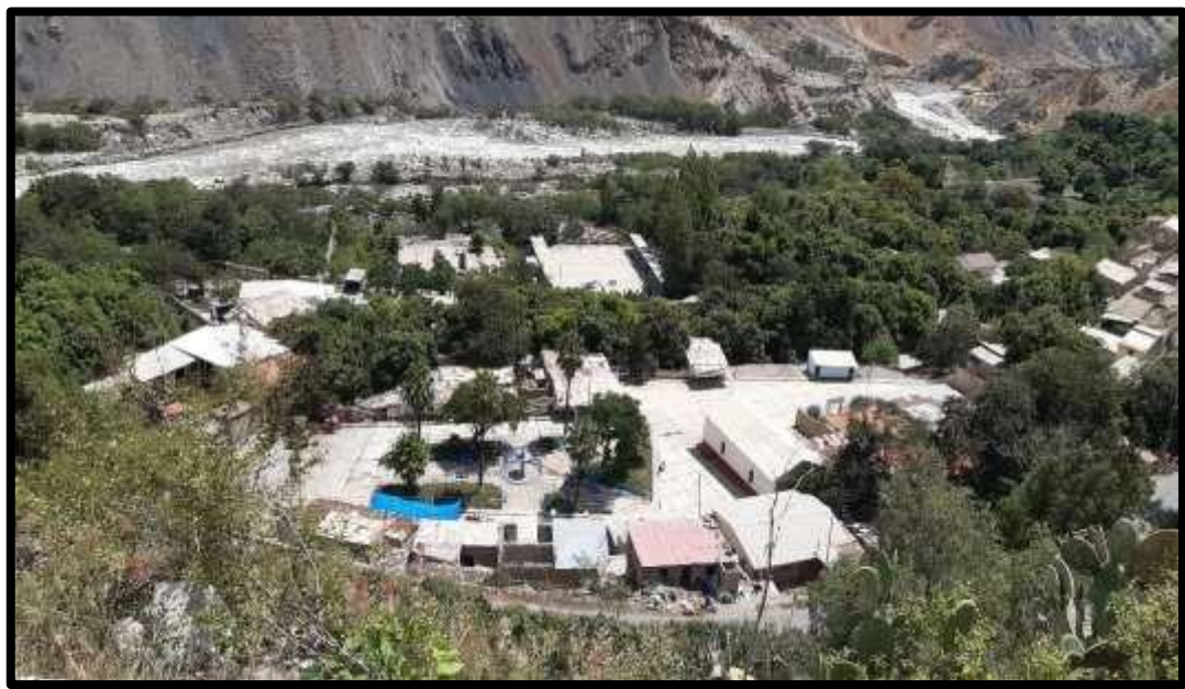
Fotografía 15. Vista de las viviendas del caserío de Eymar que abastece la red de distribución.
