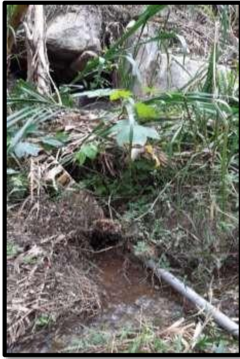
Fotografía 07. Vista de la línea de conducción entre la maleza
