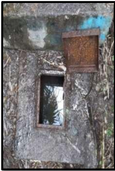
Fotografía 04. Vista de la cámara seca de la captación.
