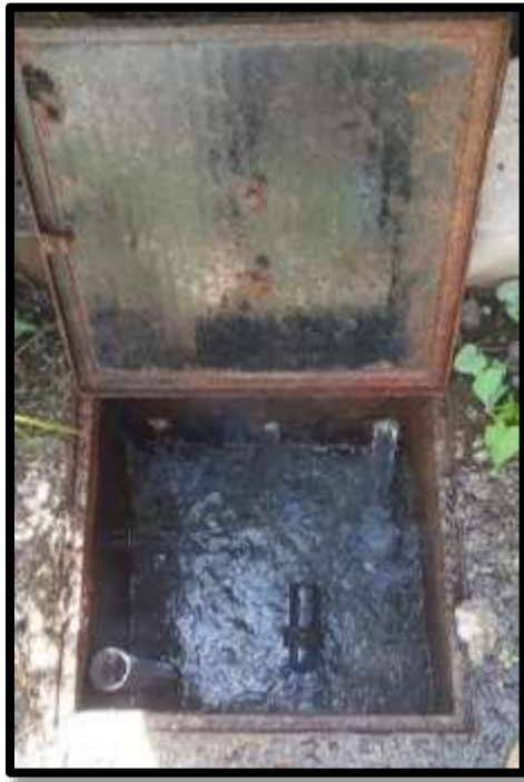
Fotografía 03. Vista de la cámara húmeda de la captación.
