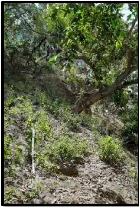
Fotografía 14. Vista de la línea de aducción a la intemperie.
